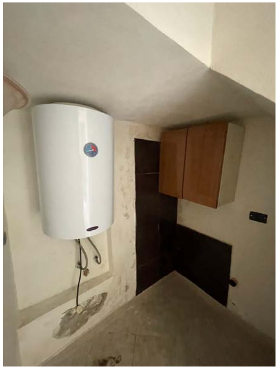
Vista del Wc 02
