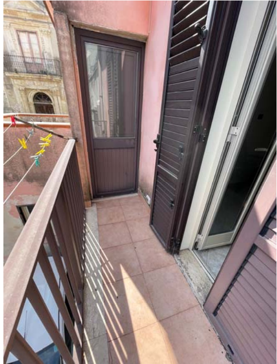
Vista del balcone 02, affaccio su Via Arimondi
