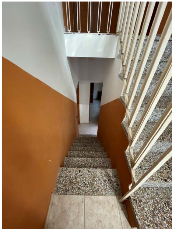
Vista della scala interna in corrispondenza dell'ingresso
