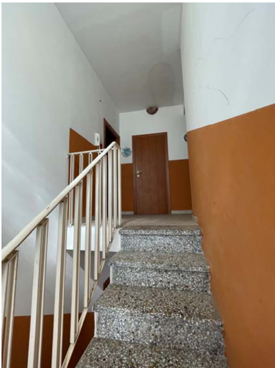
Vista della scala interna in corrispondenza dell'ingresso
