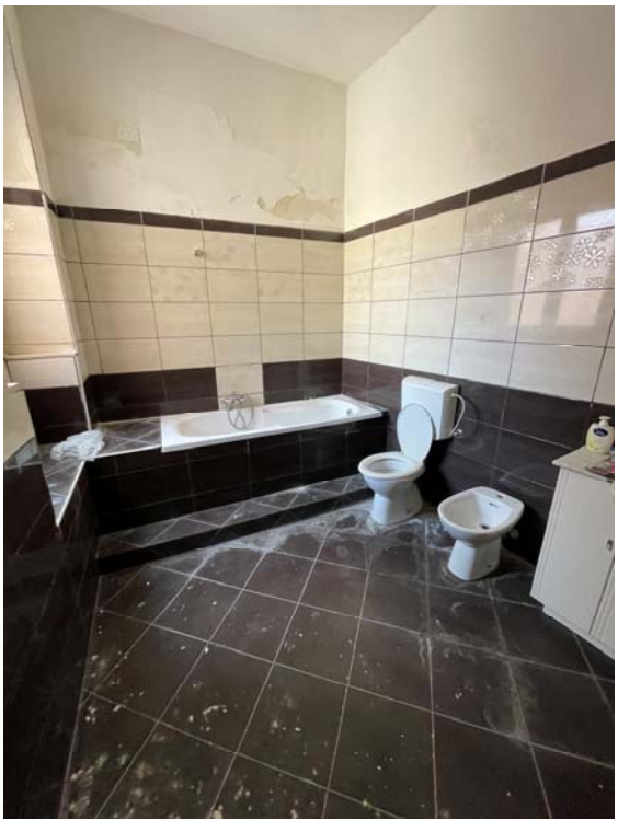
Vista del Wc 01
