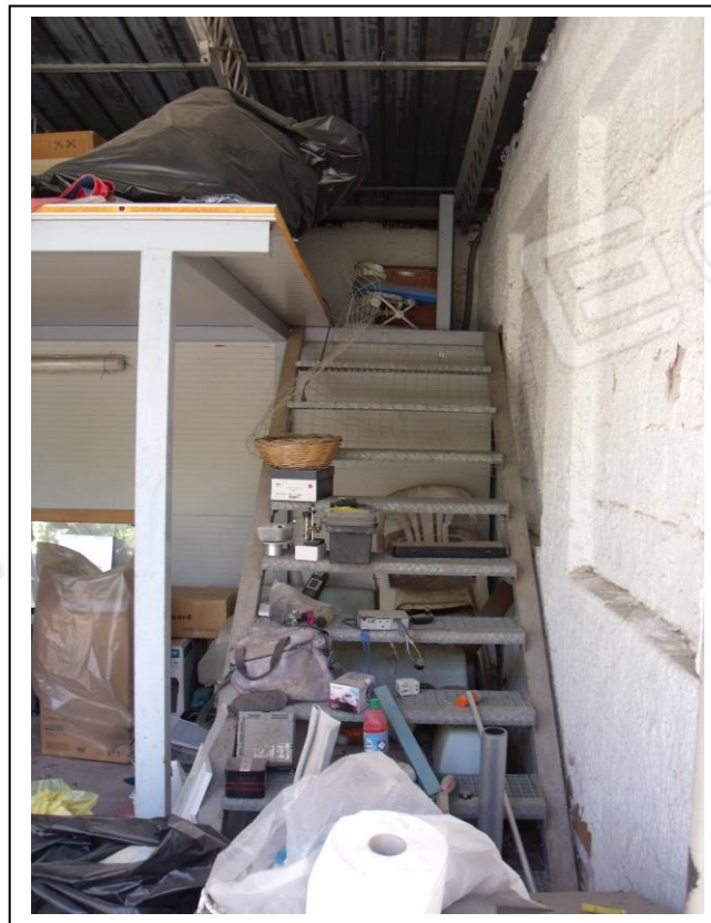
44. Interno locale garage/deposito con scala di accesso soppalco, con vista lato nord.
