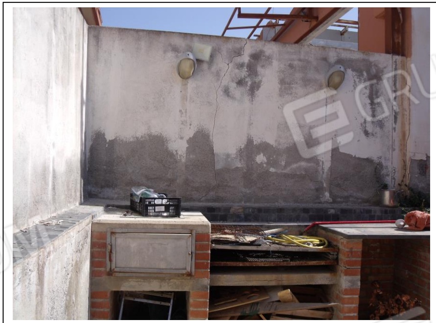
12. Area restrostante il fabbricato principale adibito ad abitazione, in foto muro di confine su due lati e presenza di ripiani cottura con forno a legna. Esposizione lato nord.
