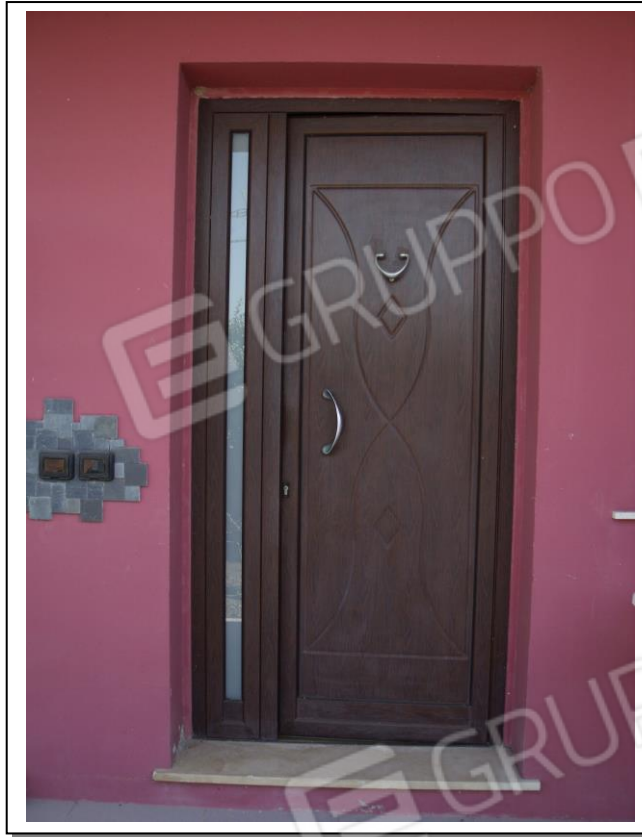
11. Portoncino d'ingresso all'unità immobiliare ad un piano fuori terra con vista lato sud-ovest.
