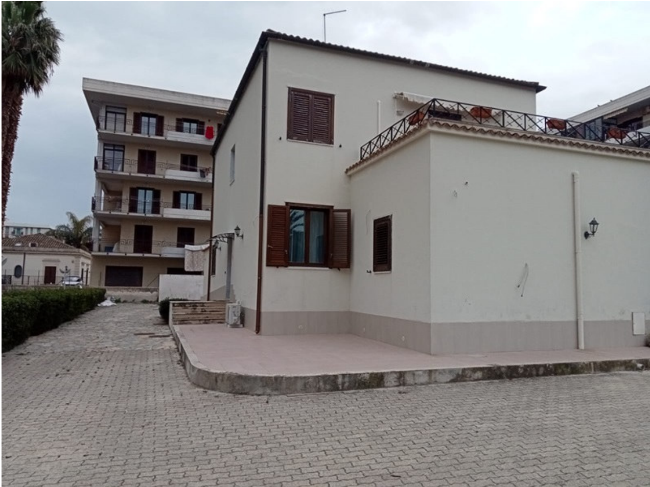
FOTO PROSPETTO NORD
