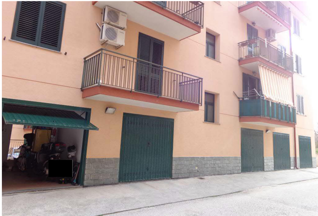
Foto 8_ lotto B: prospetto sud-ovest con infisso esterno.
