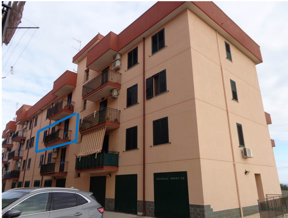
Foto 3_ prospetto nord-est su area condominiale.
