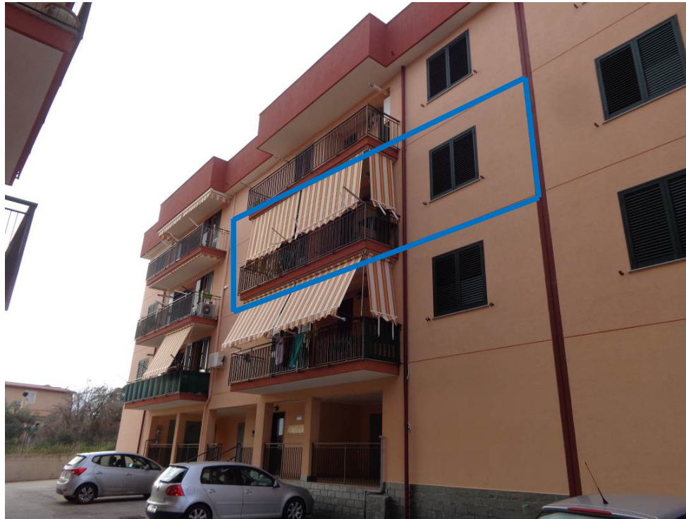
Foto 2_ prospetto sud-ovest su area condominiale.
