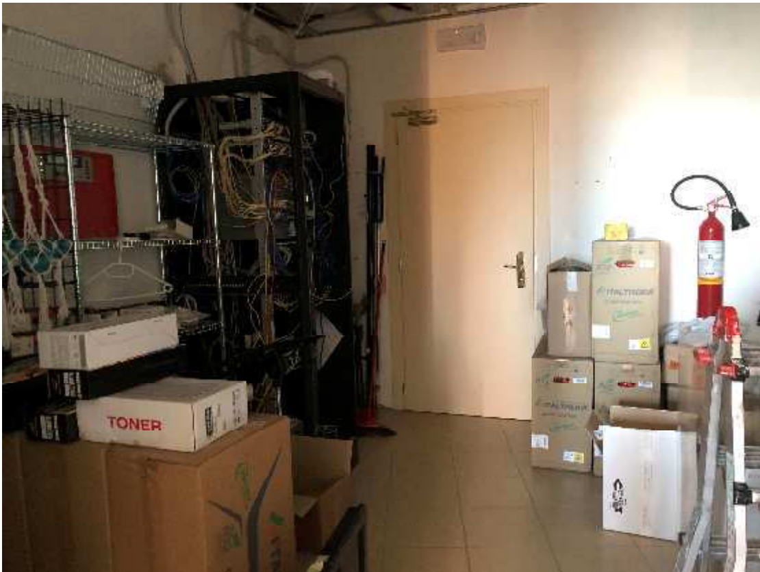
Foto 15: Vista locale q.e.
