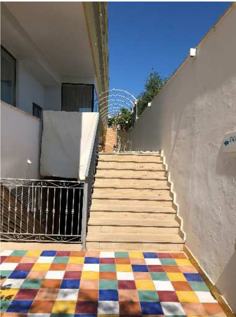
Foto 44: Vista area esterna
