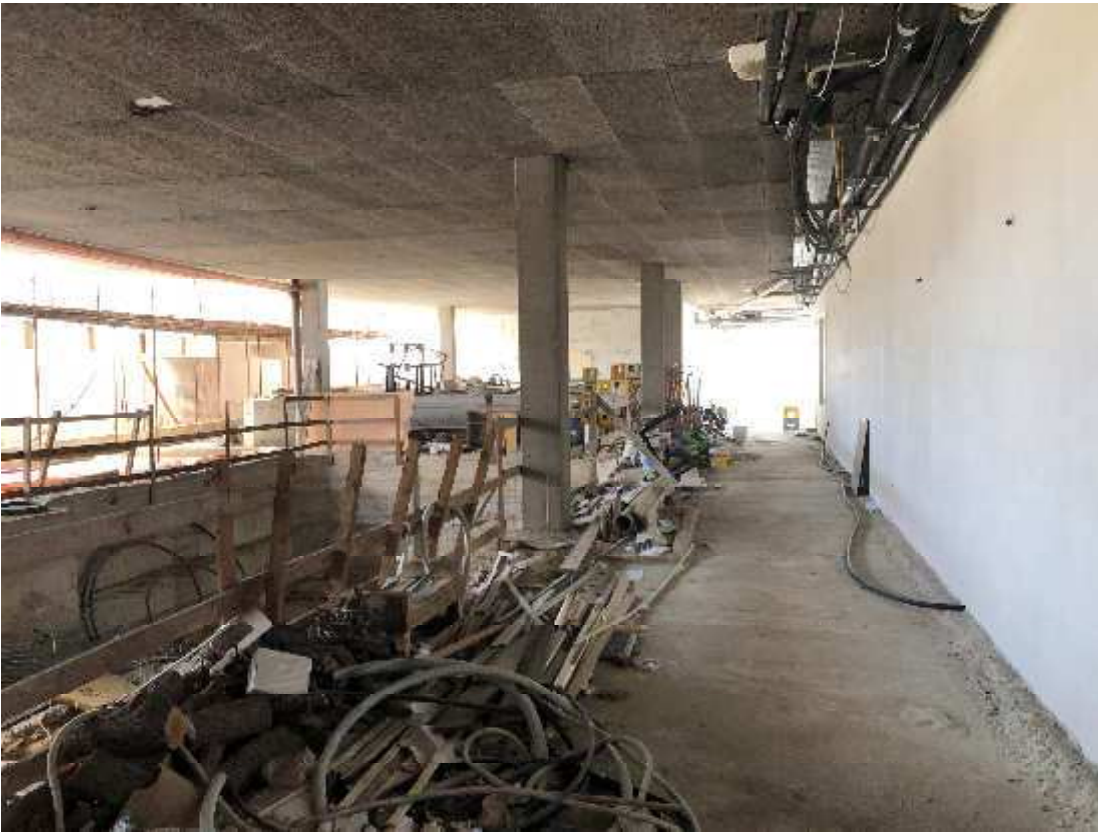
Foto 45: Vista deposito al piano cantinato
