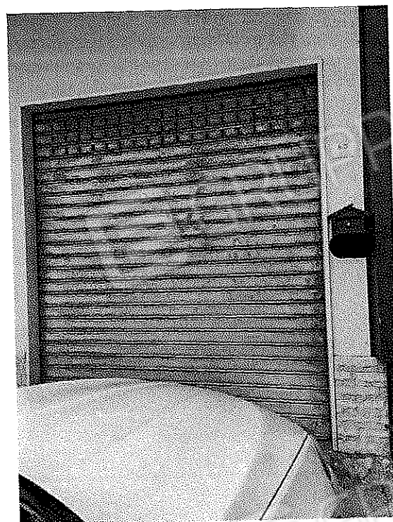
Foto 3 - Ingresso dell'autorimessa in oggetto
