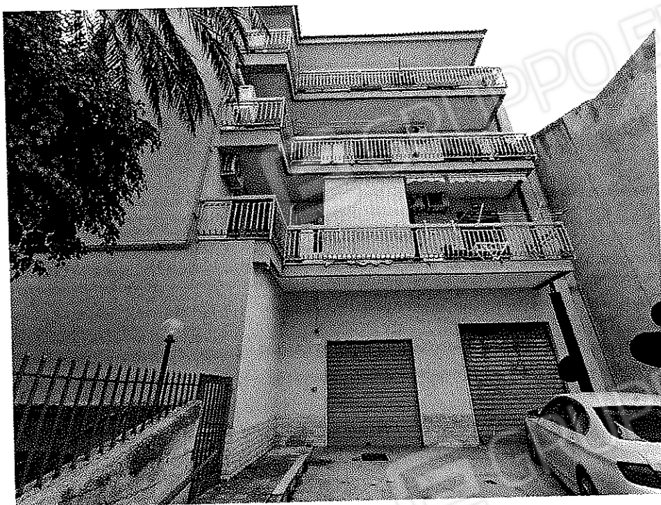
Foto 1 – Prospetto est dell'edificio condominiale. A destra, l'autorimessa in oggetto
