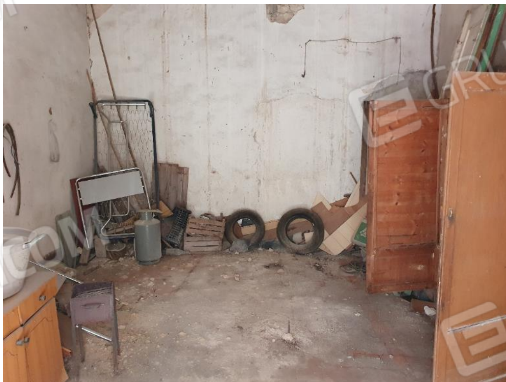
Foto n. 30 – Garage via San Michele
