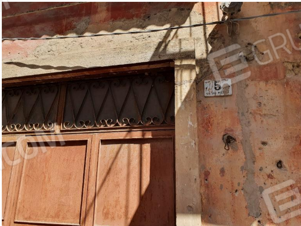
Foto n. 28 – Garage via San Michele
