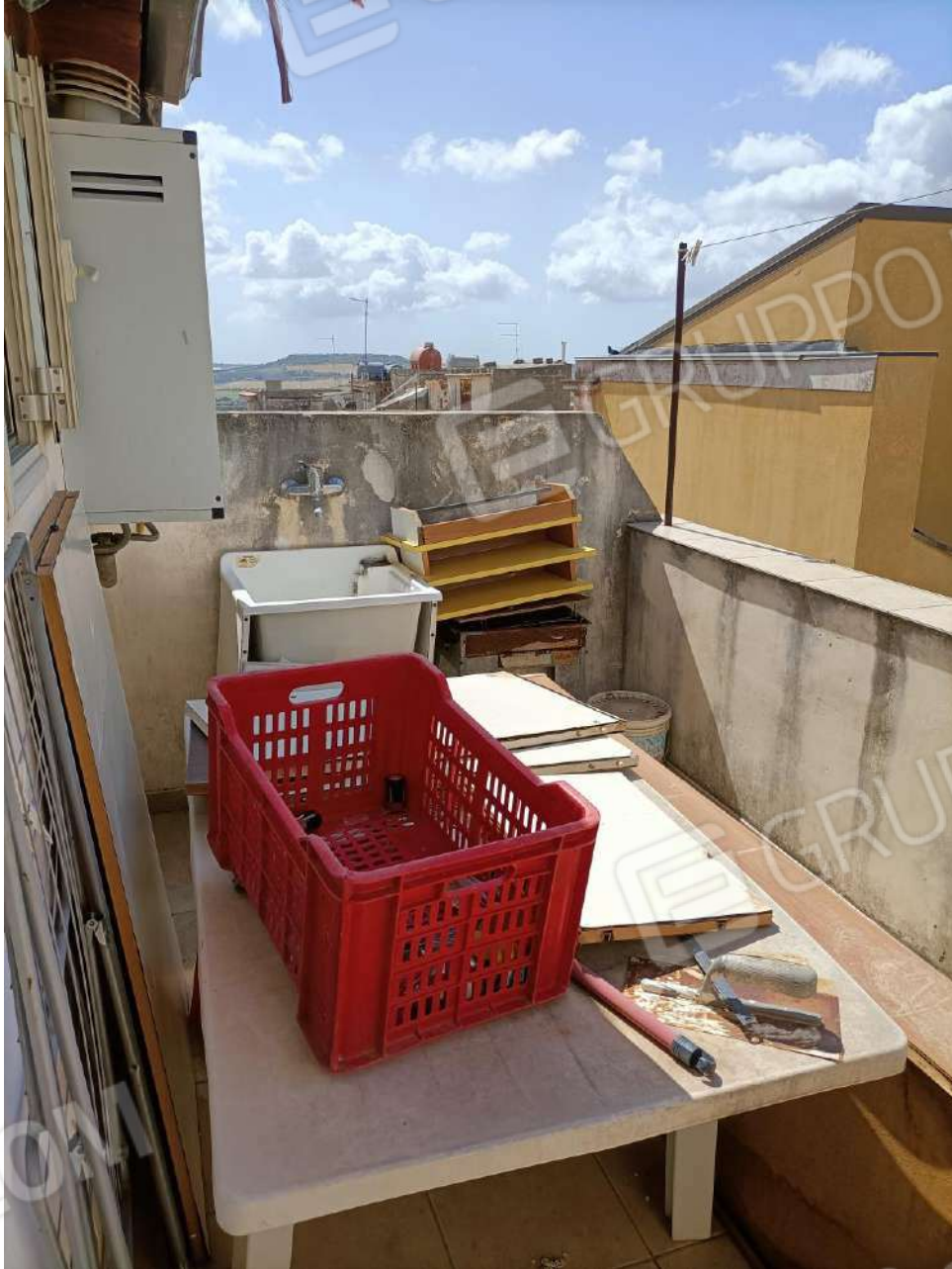
Foto 14. Vista del terrazzino.
