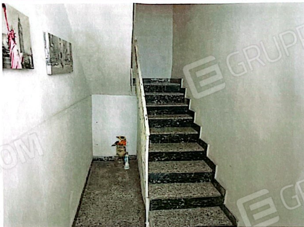
Foto 2: Vista del vano scala accessibile dal civico n. 37 della Via G. Carducci
