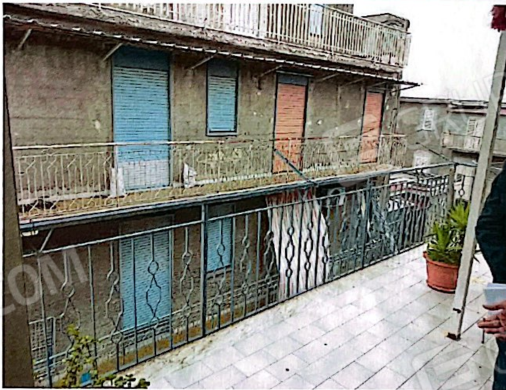
Foto 12: Vista del terrazzo al terzo piano
