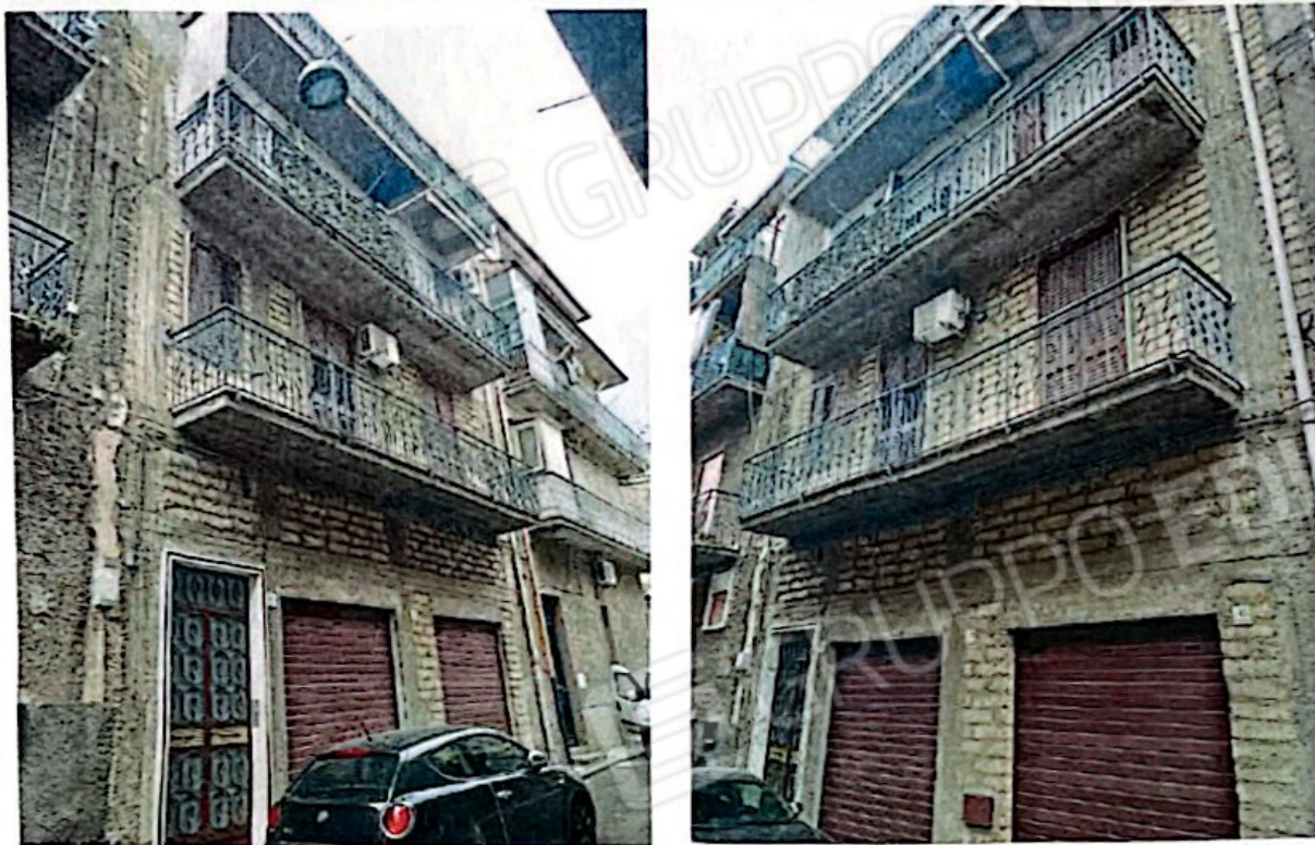
Foto 1: Vista della palazzina su quattro elevazioni sita nella Via G. Carducci n.37-39-41
