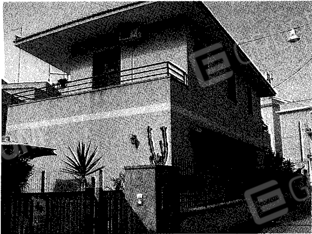
FOTO N. 2: PROSPETTO SUD ED EST (RONCO II A VIA FILISTO)
