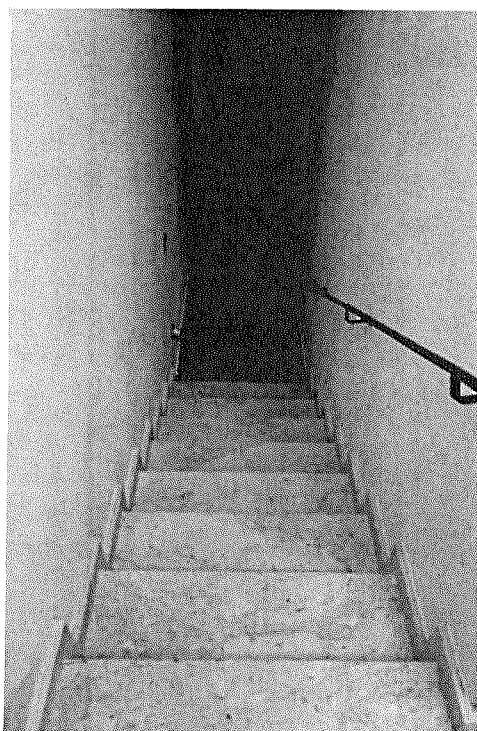
9_la rampa di scale che conduce al piano seminterrato
