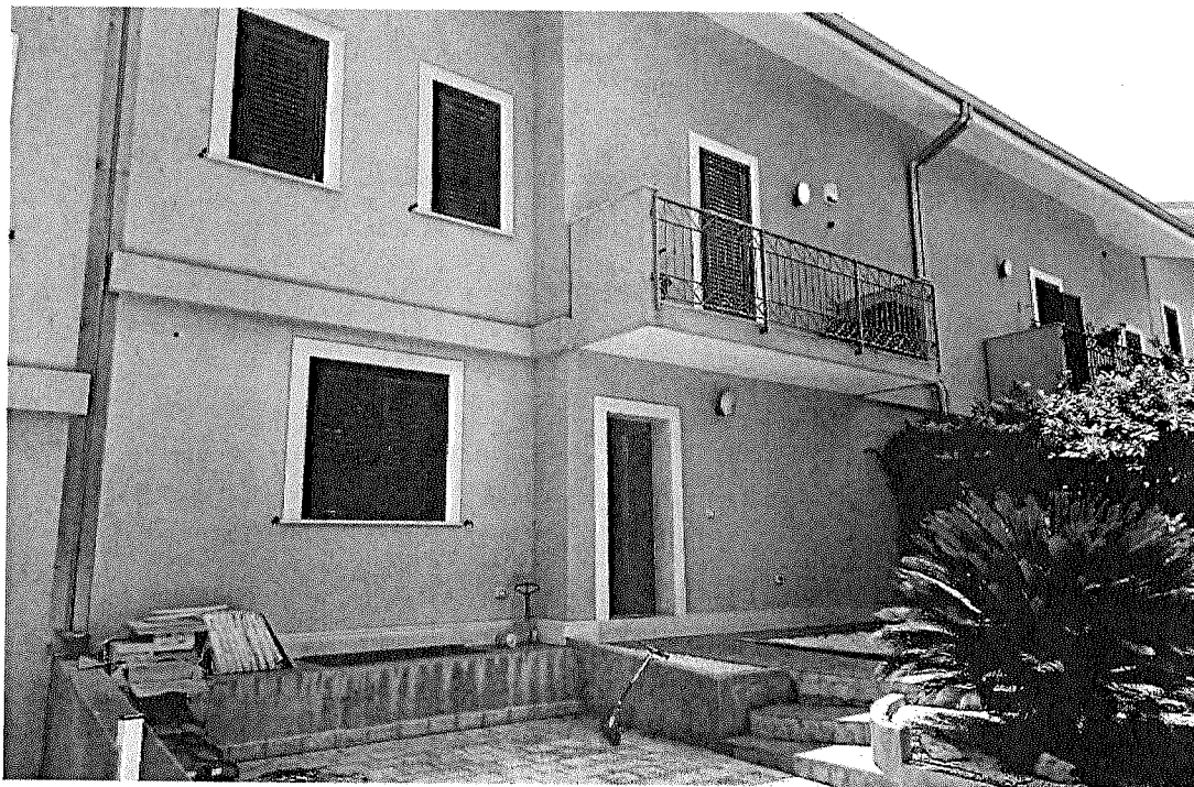
2 L'ingresso al bene dalla Via Archimede
