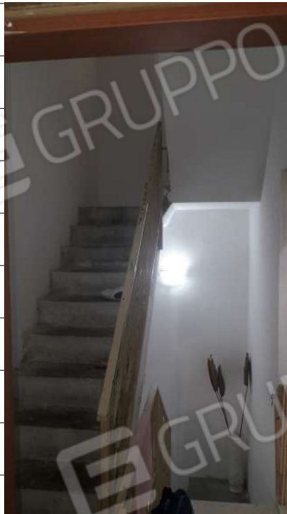
Foto n.25: immagine interna del vano scala di collegamento tra i piani secondo e terzo.
