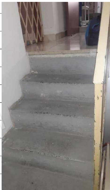
Foto n.20: immagine interna del vano scala di collegamento tra i piani primo e secondo.
