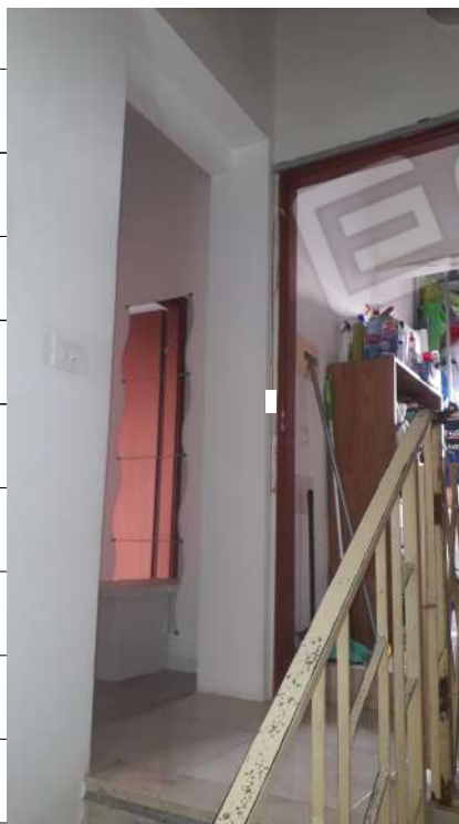
Foto n.26: immagine interna del vano scala di collegamento tra i piani secondo e terzo.
