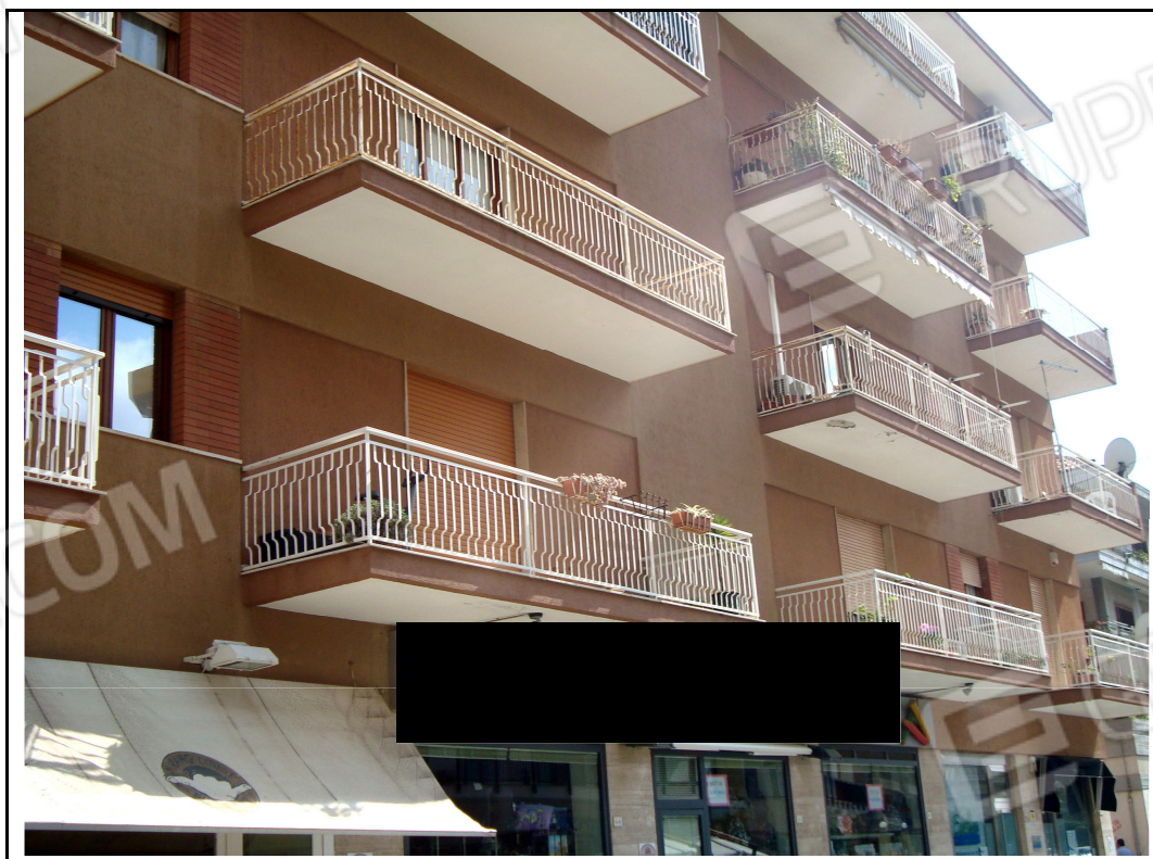
FOTO 2. Vista del prospetto principale dell'edificio su via Senatore Di Giovanni
