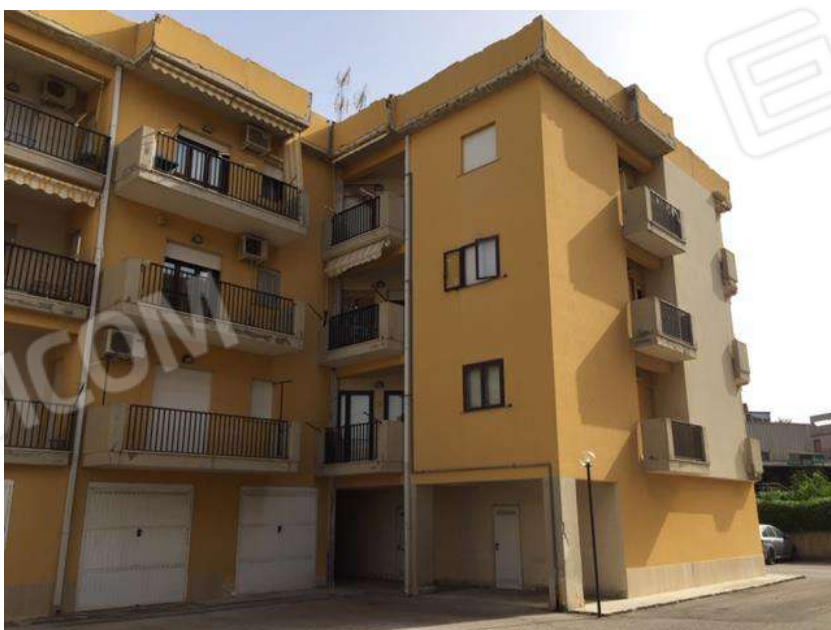
Foto 8. Prospetto su corte comune.
