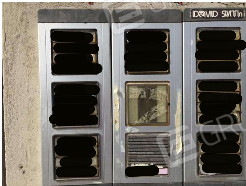
Foto 5. Citofono del complesso residenziale.
