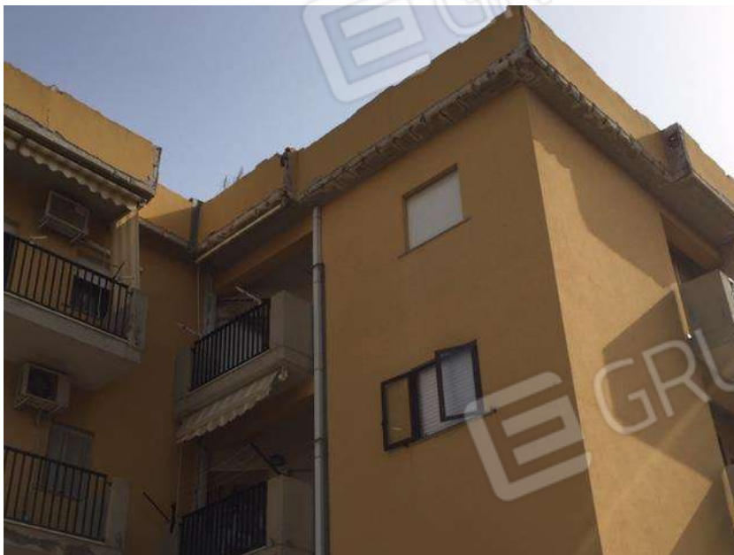
Foto 9. Dettaglio prospetto su corte comune.
