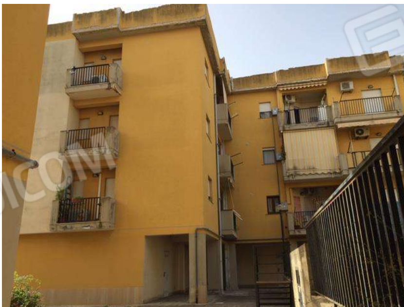
Foto 10. Prospetto su corte comune.
