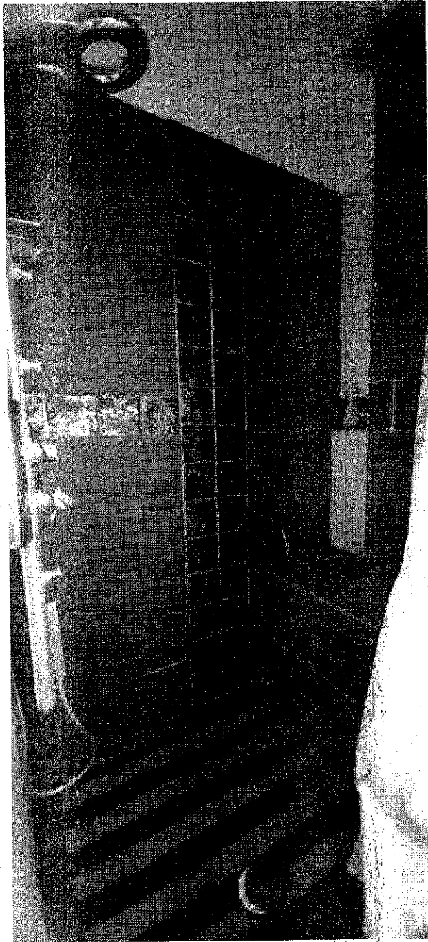
Foto 13 – Immobile “1A” – Bagno
