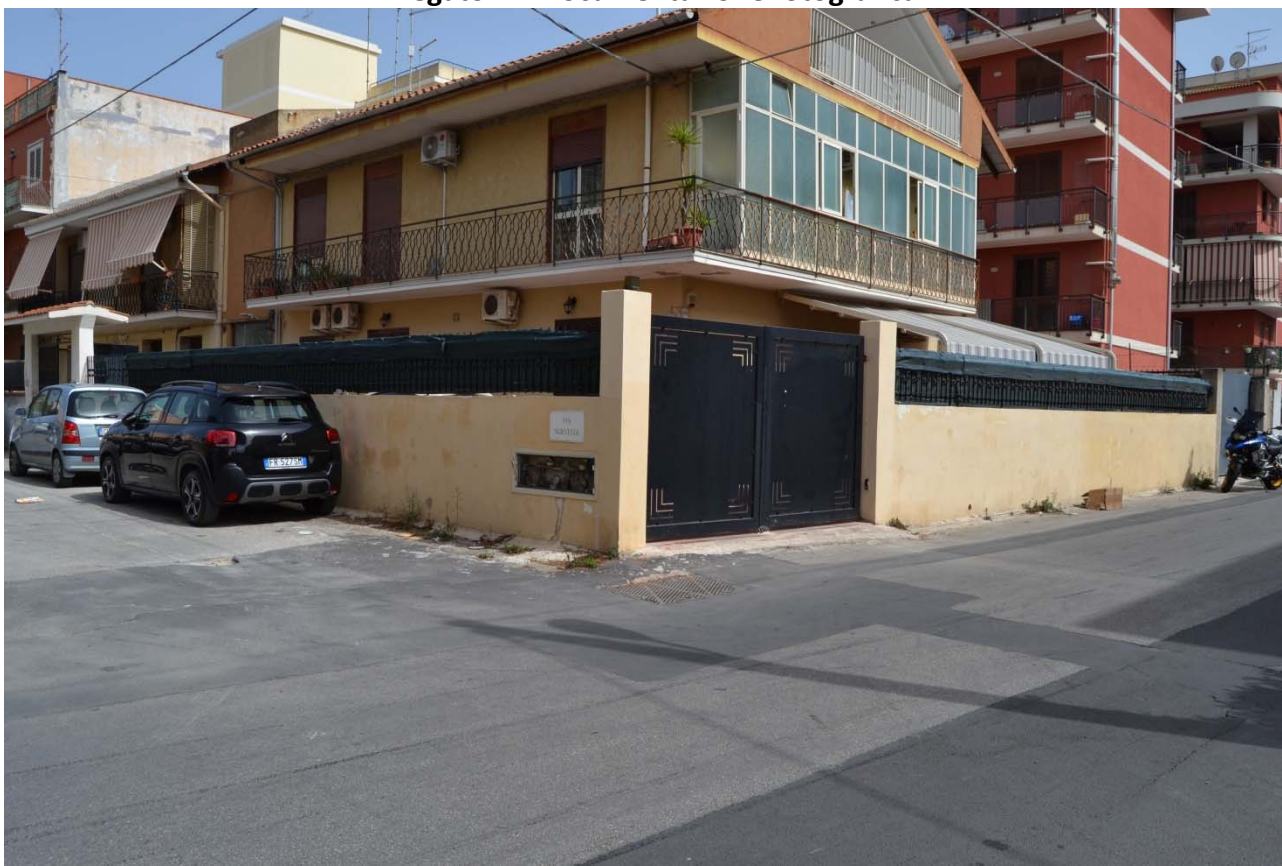
Foto 1 – Immobile - abitazione in Siracusa Via Norvegia n.2 – piano terra.
