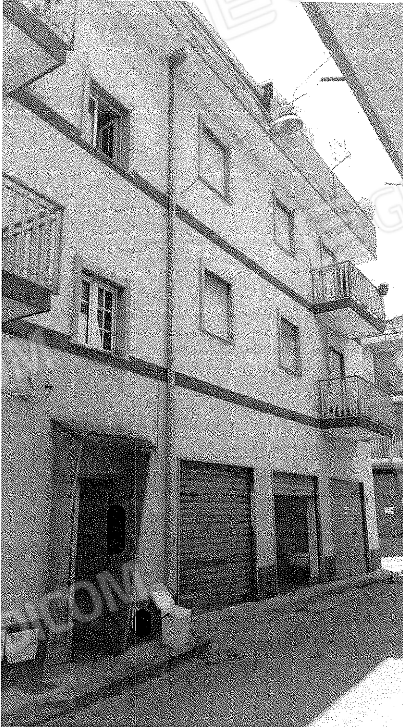
G.05 - Esterno dell'edificio in cui è ubicato l'appartamento e veduta del portone d'ingresso al vano scala comune, Via Firenze n. 61, piani secondo e terzo.
