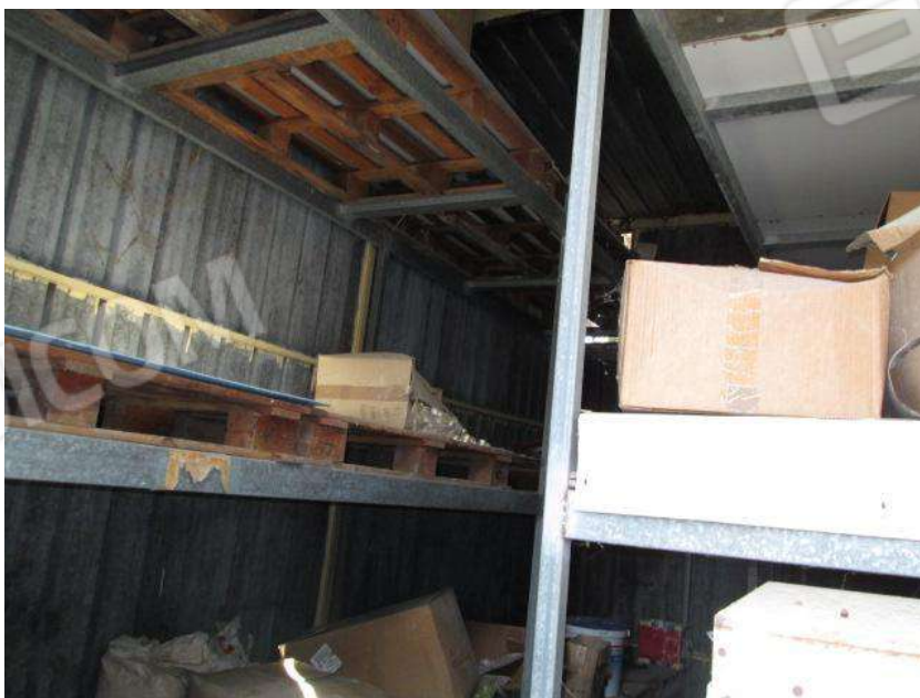
Foto 64. Vista interna del Corpo F.3 - Deposito.
