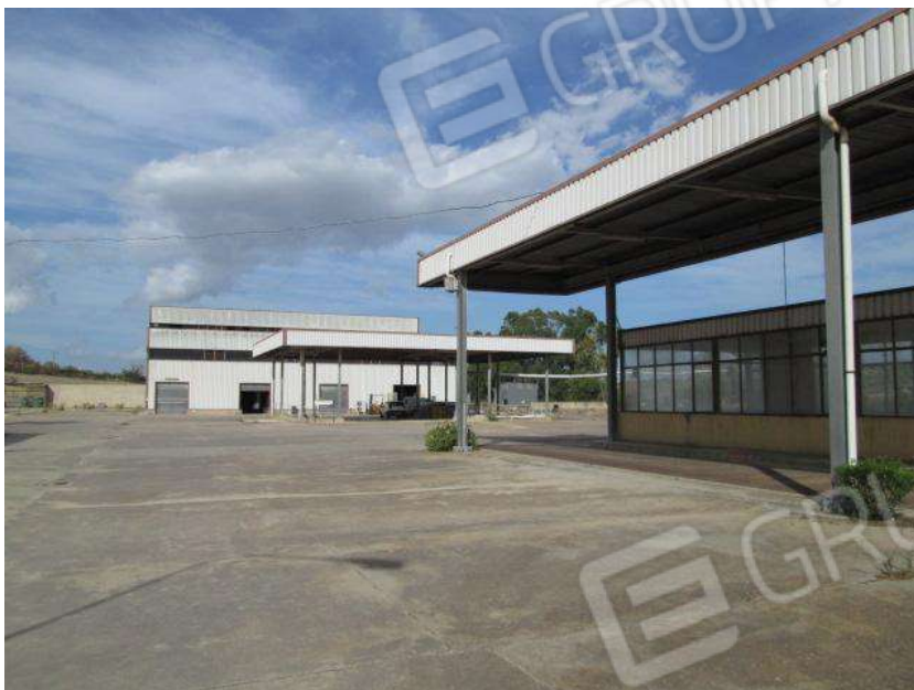
Foto 7. Vista generale del complesso immobiliare.
