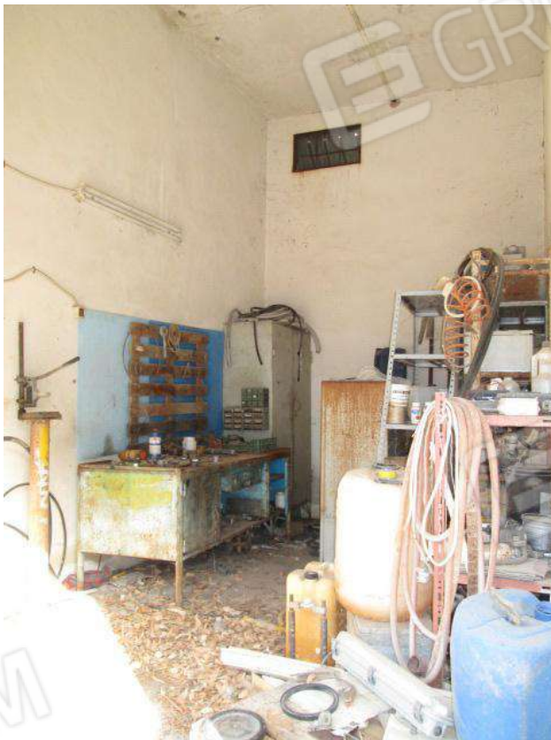
Foto 63. Vista interna del Corpo F.3 - Deposito.
