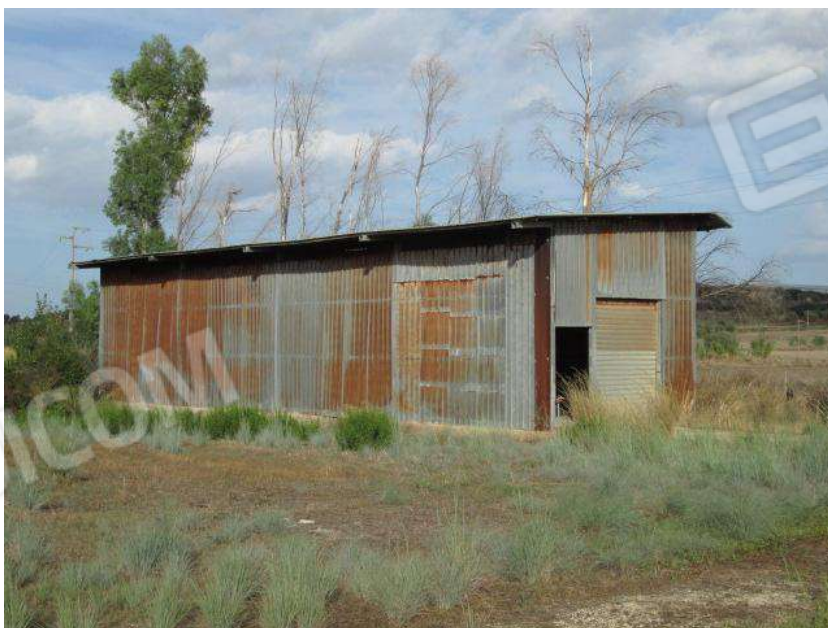
Foto 68. Vista esterna del Corpo F.2 - Deposito.
