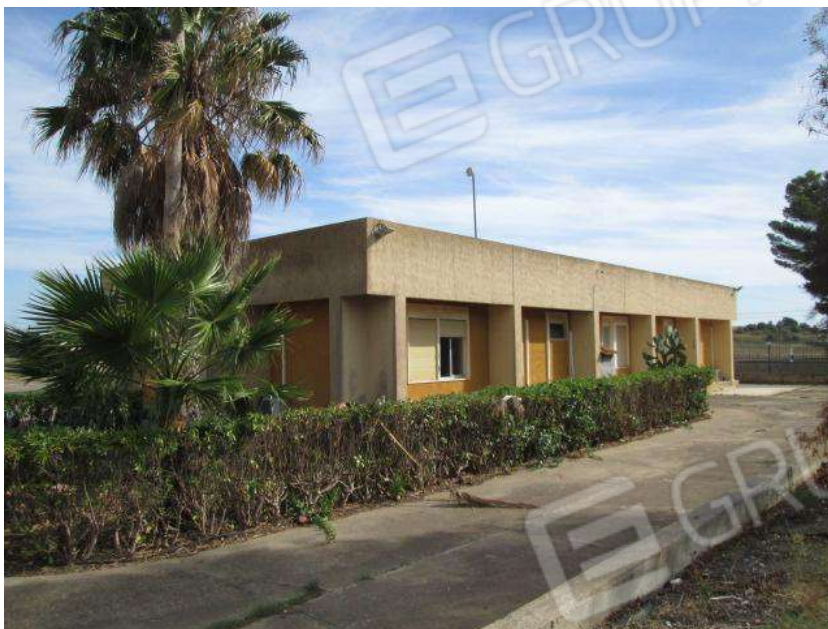
Foto 19. Vista esterna del Corpo A.
