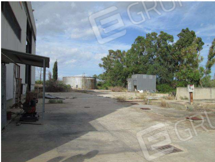
Foto 13. Vista generale del complesso immobiliare.
