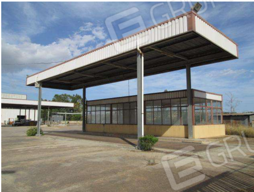
Foto 55. Vista esterna del Corpo E.
