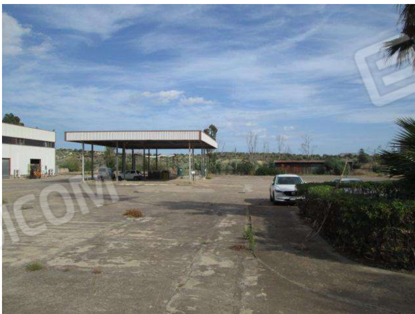
Foto 8. Vista generale del complesso immobiliare.
