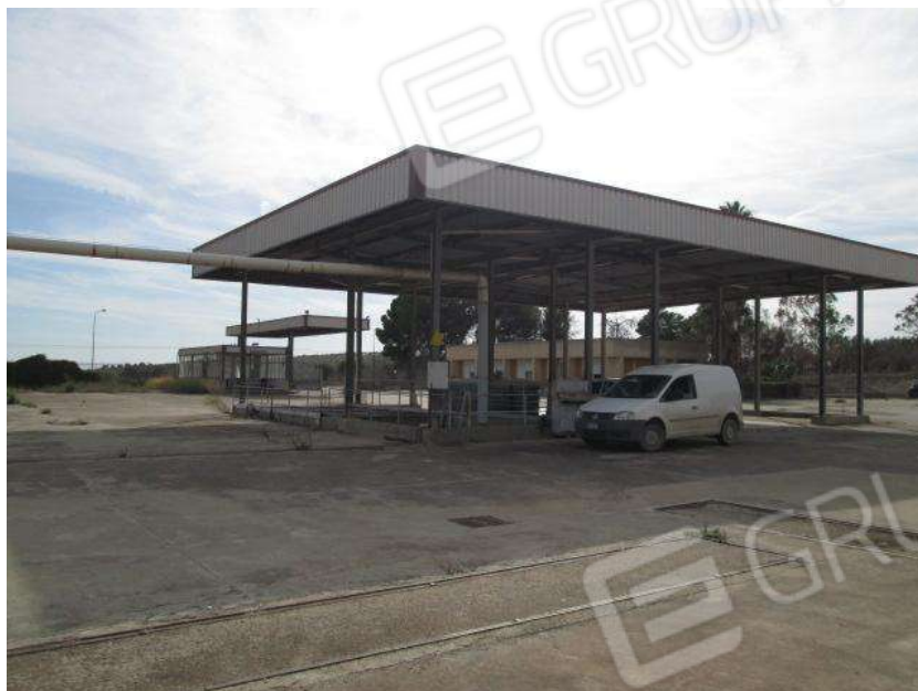
Foto 15. Vista generale del complesso immobiliare.
