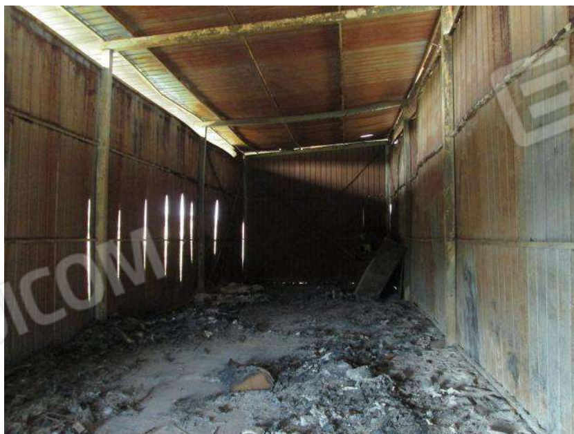
Foto 70. Vista interna del Corpo F.2 - Deposito.
