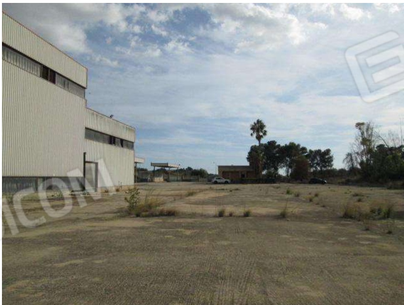
Foto 12. Vista generale del complesso immobiliare.
