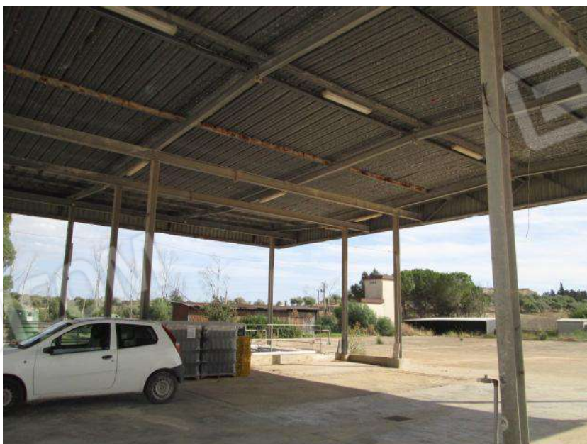
Foto 74. Vista esterna del Corpo G.
