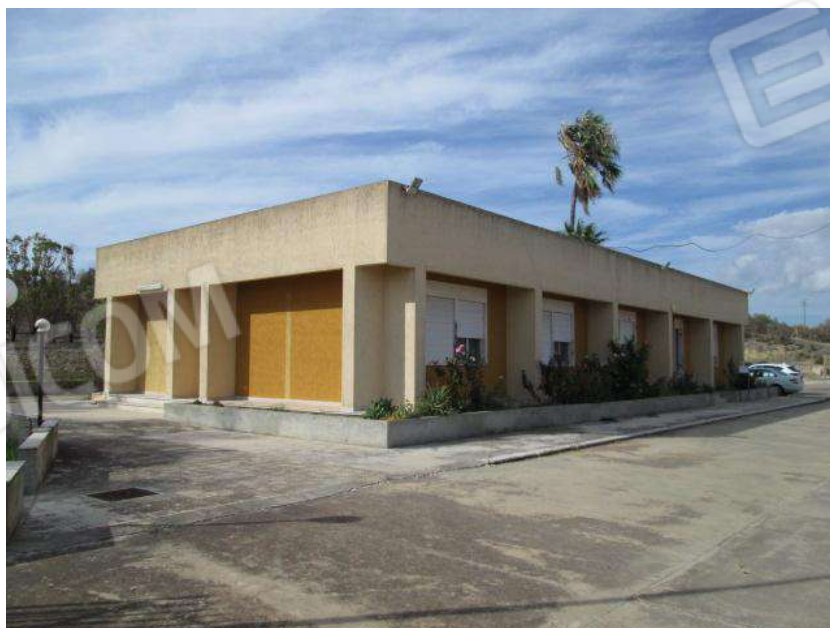
Foto 16. Vista esterna del Corpo A.
