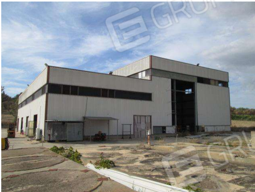
Foto 39. Vista esterna del Corpo B.
