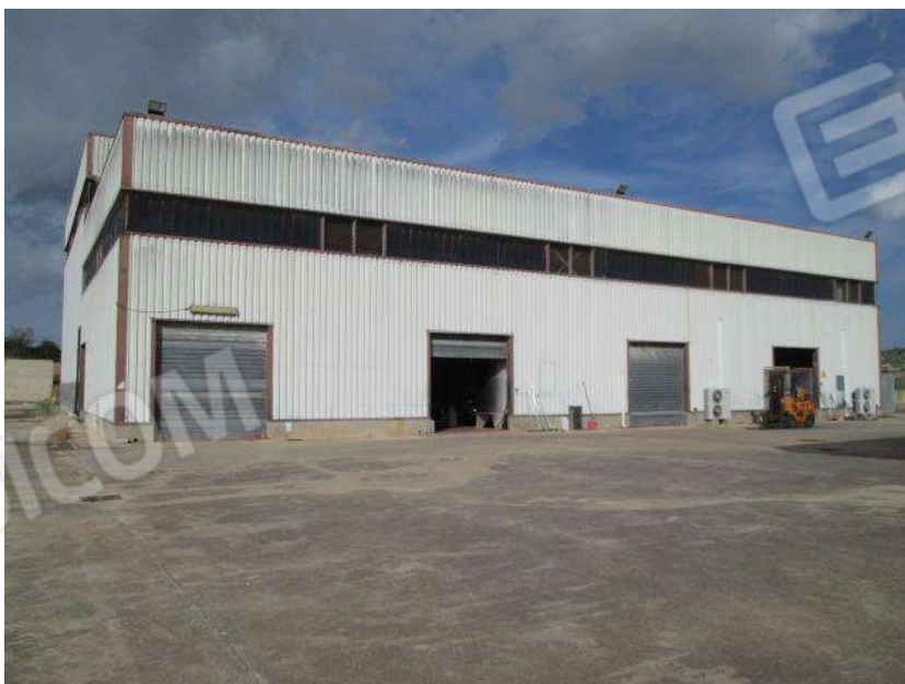
Foto 38. Vista esterna del Corpo B.
