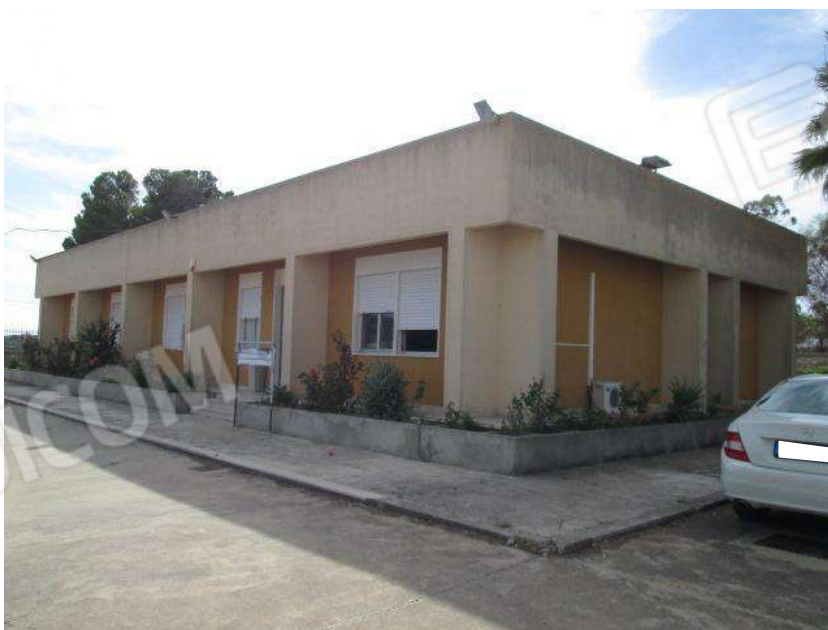
Foto 18. Vista esterna del Corpo A.
