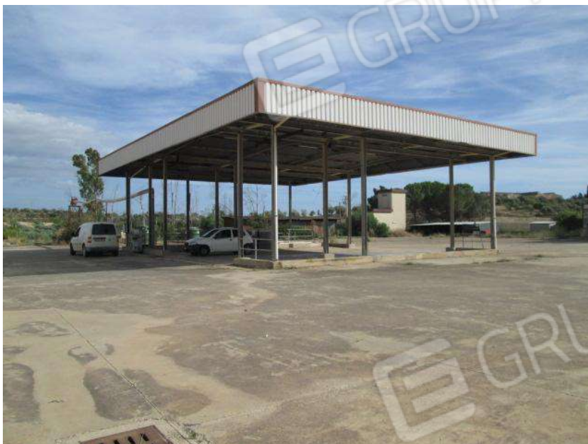
Foto 73. Vista esterna del Corpo G.
