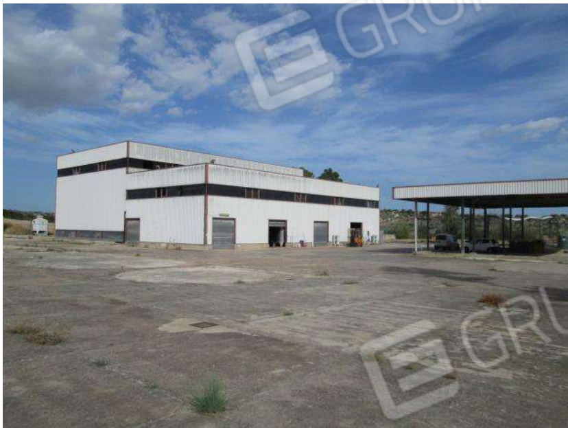
Foto 37. Vista esterna del Corpo B.
