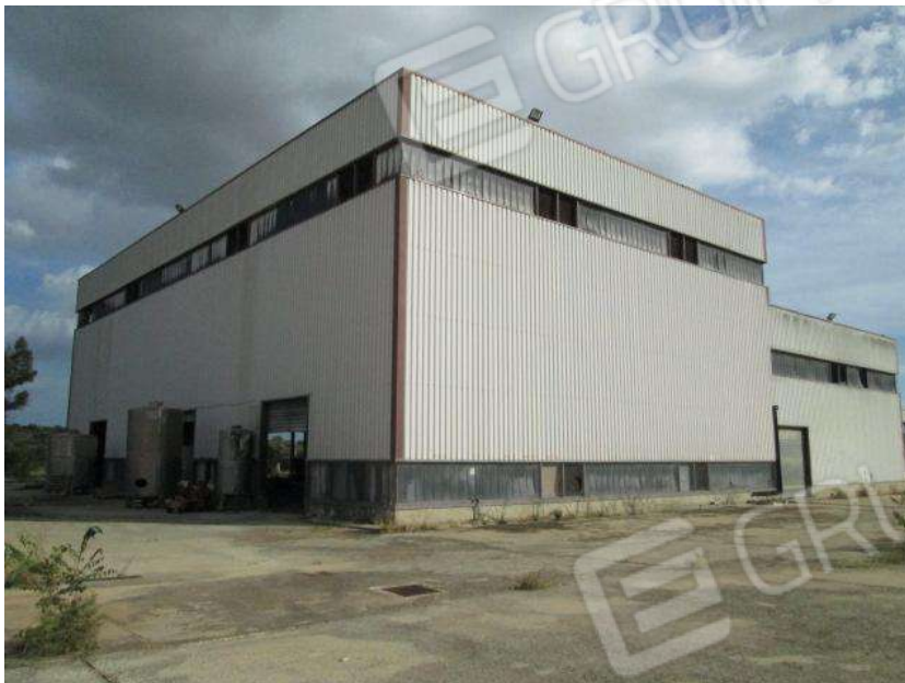
Foto 41. Vista esterna del Corpo B.
