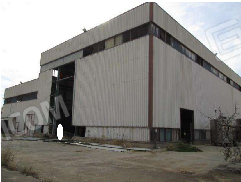
Foto 40. Vista esterna del Corpo B.
