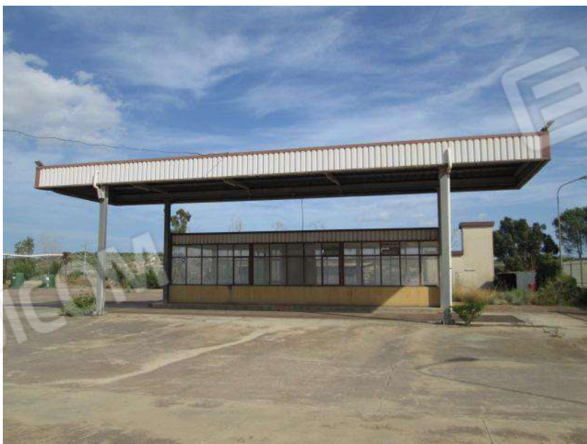
Foto 56. Vista esterna del Corpo E.
