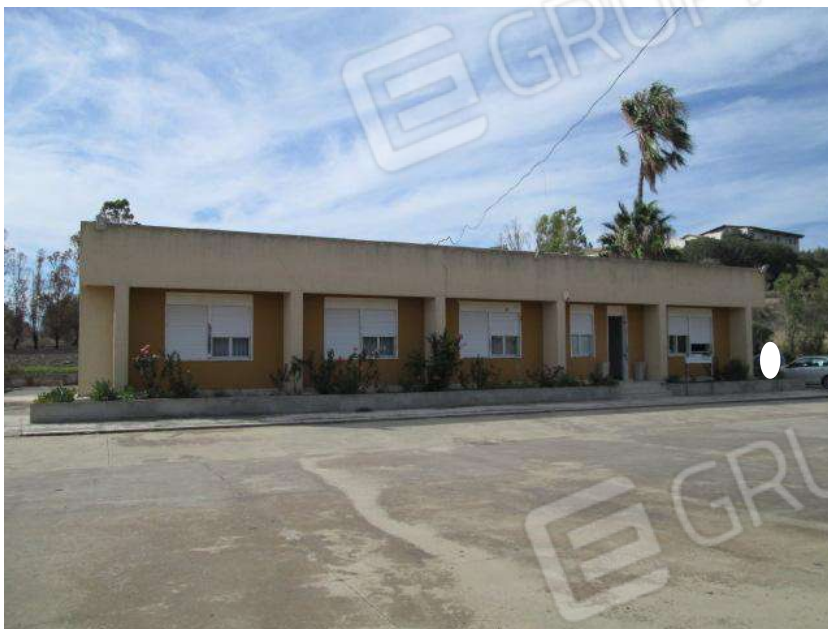
Foto 17. Vista esterna del Corpo A.
