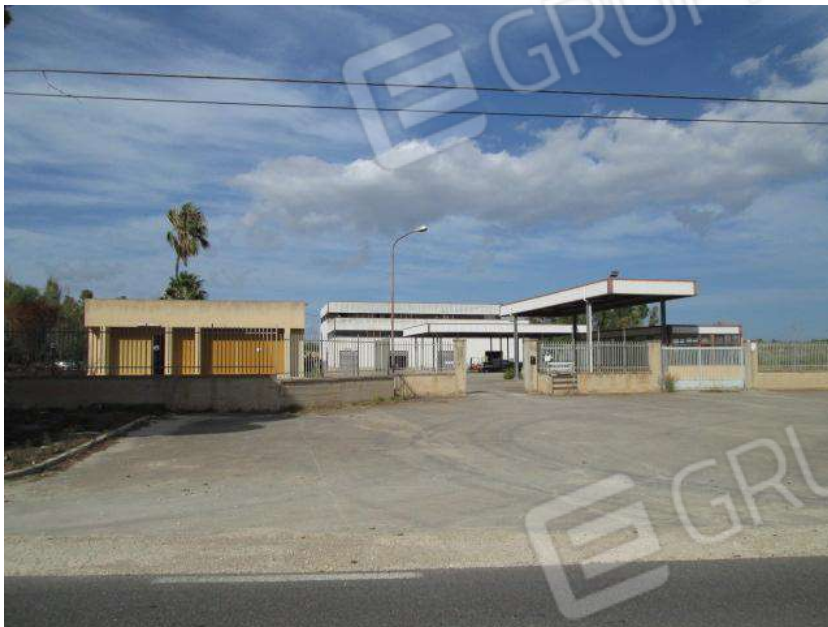
Foto 5. Ingresso al complesso immobiliare dal piazzale adiacente la SP 26.
