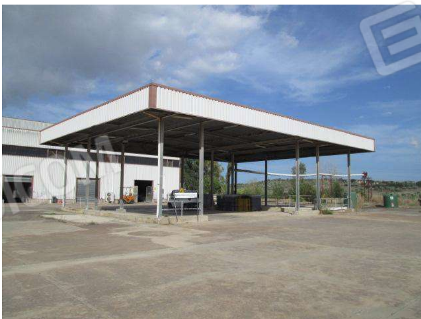
Foto 72. Vista esterna del Corpo G.
