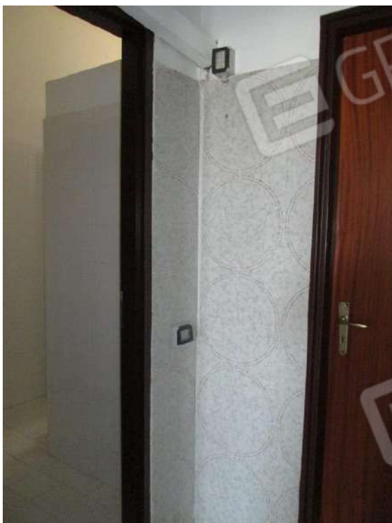
Foto 27. Antibagno e ingresso spogliatoio e zona docce.
