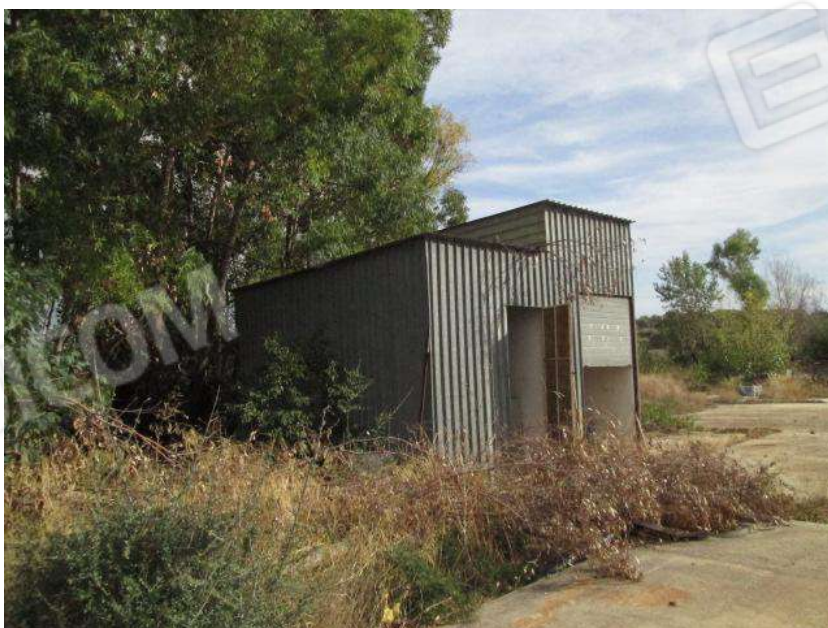
Foto 62. Vista esterna del Corpo F.3 - Deposito.
