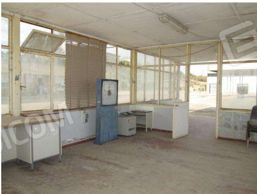
Foto 60. Locale Ingresso e pesatura.
