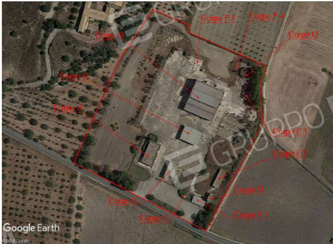
Foto 1. Vista del complesso immobiliare ed individuazione dei Corpi A-B-C-D-E-F.1-F.2-F.3-F.4-F.5-G-Q.
