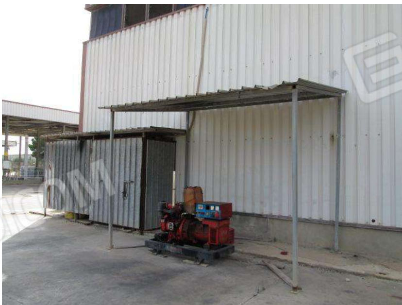
Foto 50. Vista esterna del Corpo B - tettoie.
