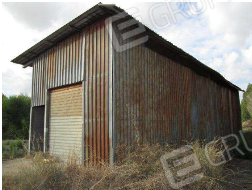
Foto 69. Vista esterna del Corpo F.2 - Deposito.
