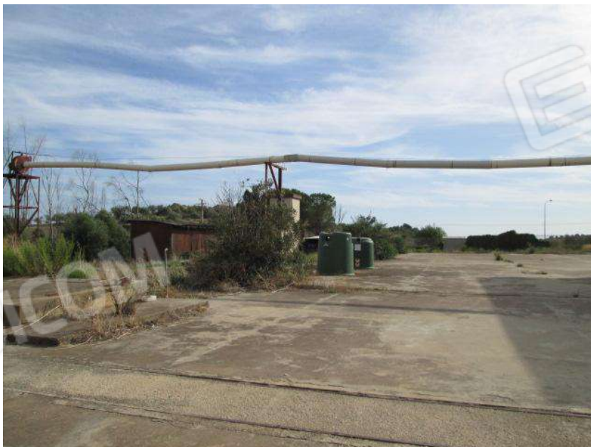
Foto 14. Vista generale del complesso immobiliare.
