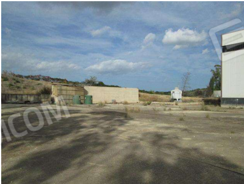
Foto 10. Vista generale del complesso immobiliare.
