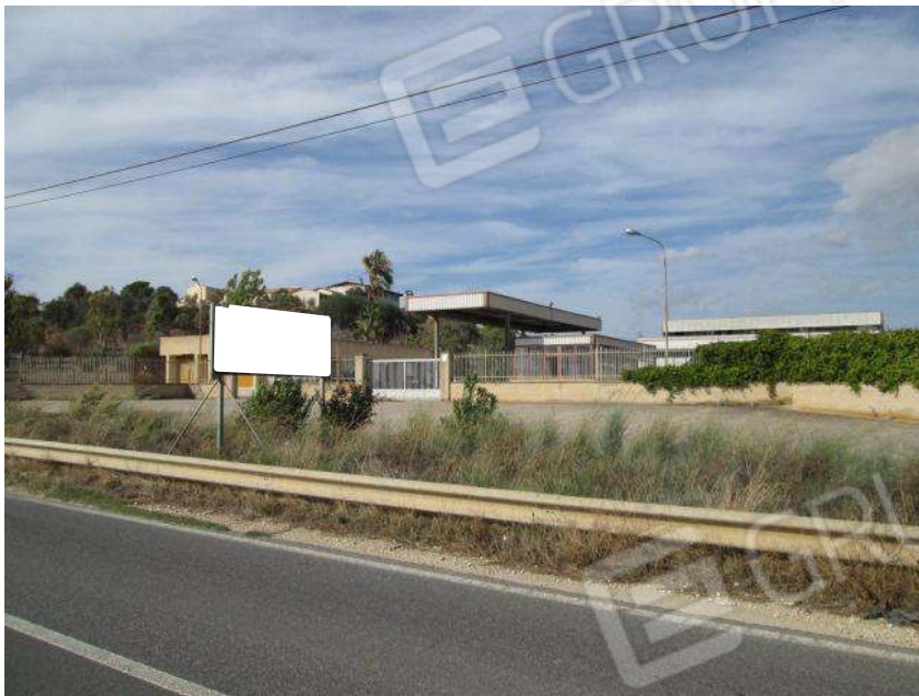
Foto 3. Vista esterna del complesso immobiliare dalla SP 26.
