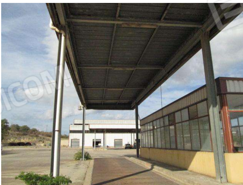
Foto 54. Vista esterna del Corpo E.
