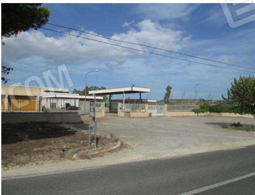
Foto 2. Vista esterna del complesso immobiliare dalla SP 26.
