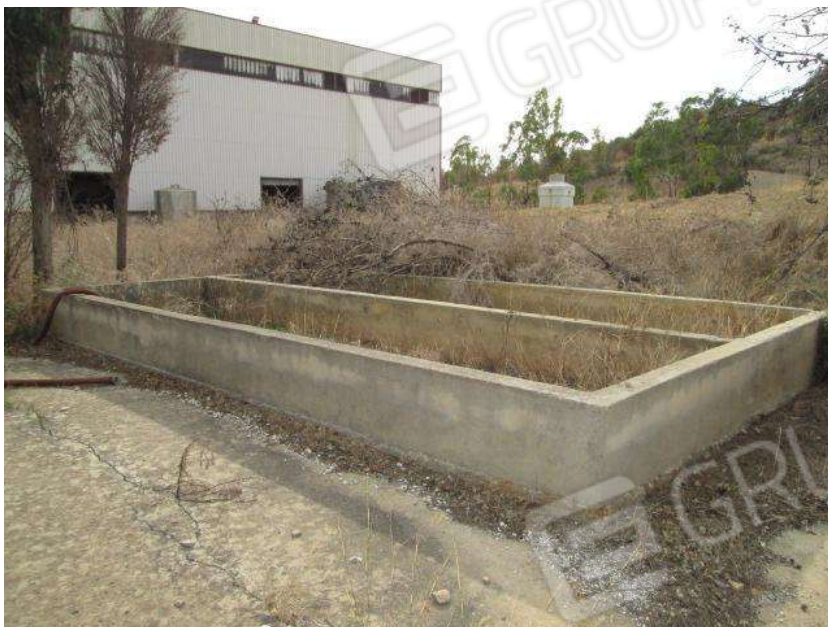
Foto 65. Vista esterna del Corpo F.4 - Vasche di sedimentazione.
