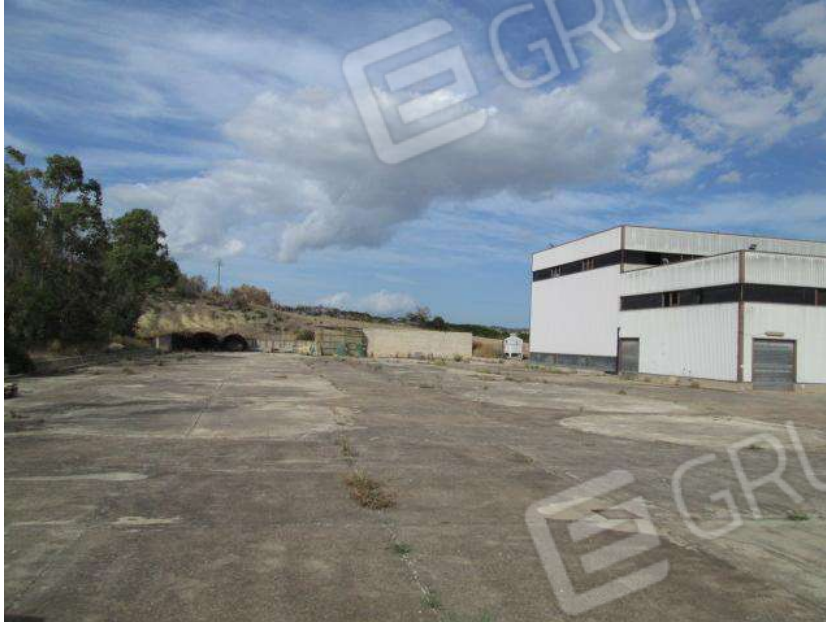
Foto 9. Vista generale del complesso immobiliare.
