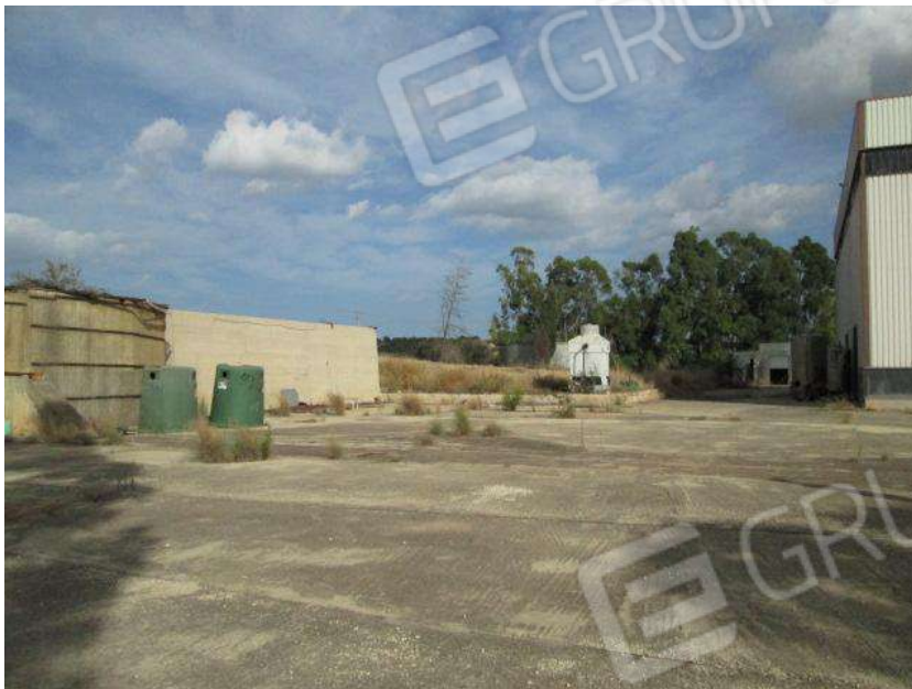
Foto 11. Vista generale del complesso immobiliare.
