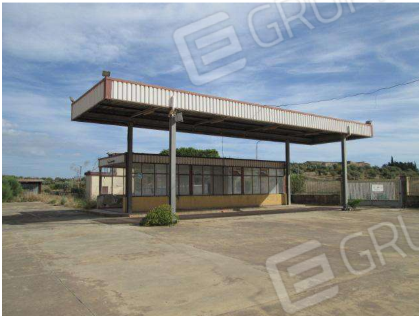
Foto 57. Vista esterna del Corpo E.
