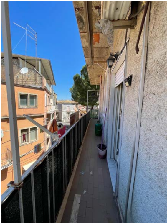
Balcone su Via Volturmo
