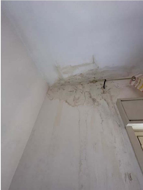
Condizioni di manutenzione interna
