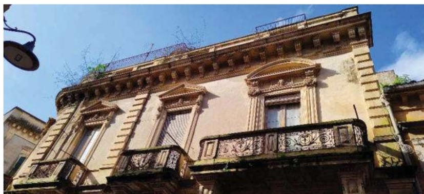
Foto 19: facciata lato Est
