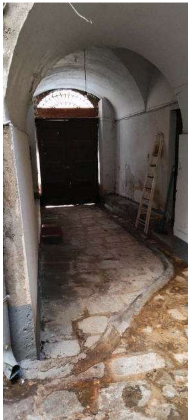
Foto 29: ingresso condominiale via Caprera 11
