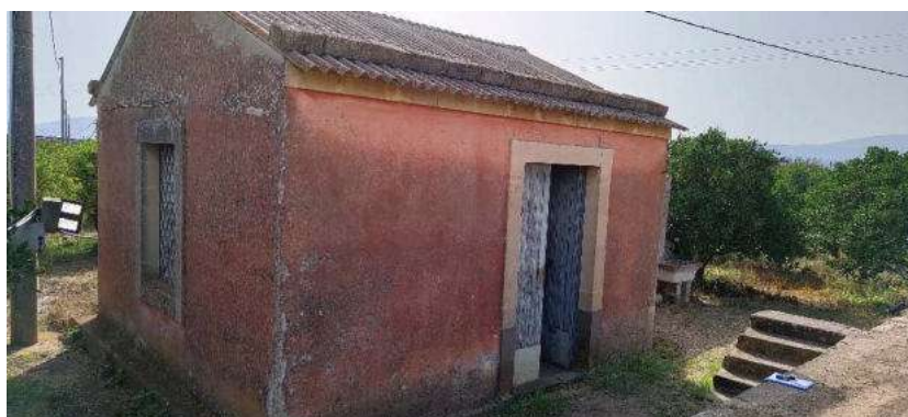
Figura 4 locale tecnico pozzo su p.la 190
