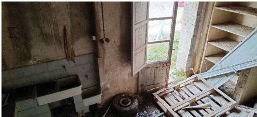
Foto 60 deposito lato nord
