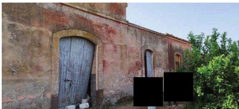
Foto 6: prospetto lato nord piano terra
