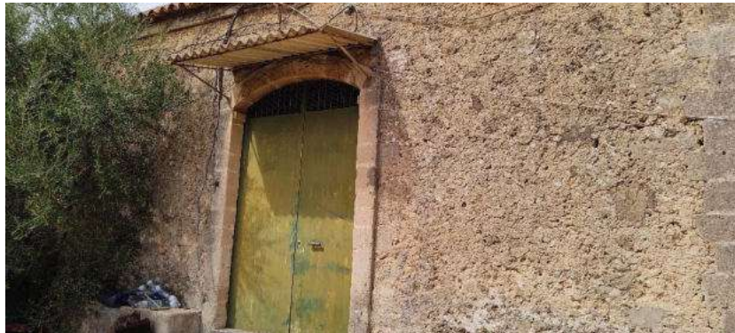
Foto 52 ingresso deposito carburante lato Sud
