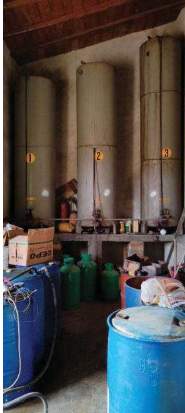
Foto 51 locale deposito carburante lato Sud
