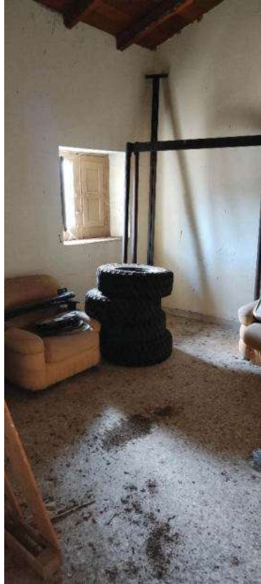
Foto 45: vano casa custode
