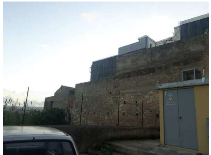
Immobile Esterno lato Ovest
