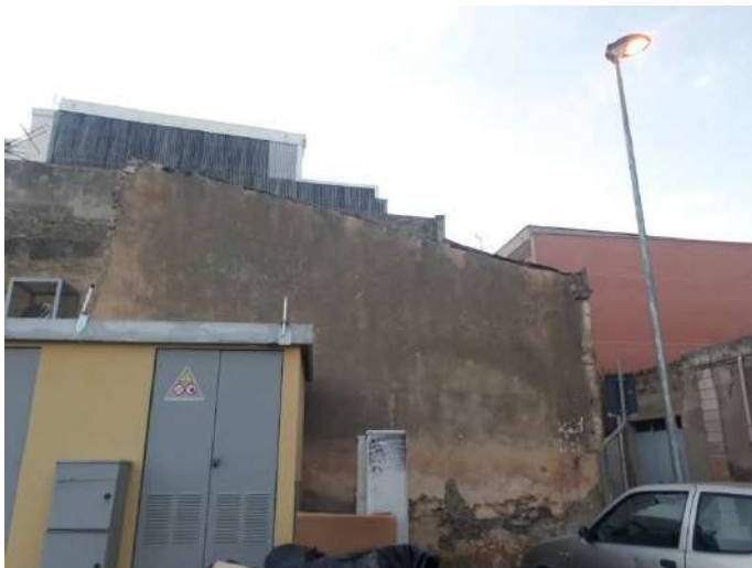
Immobile Esterno lato Ovest
