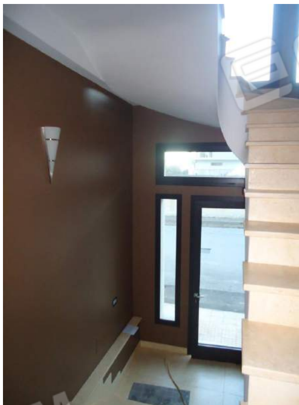
Foto n. 4 – Androne e vano scala
