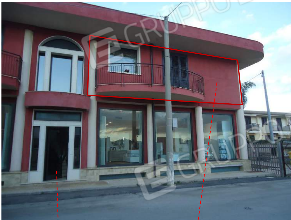
Foto n. 3 – Edificio di via Rinaldi
