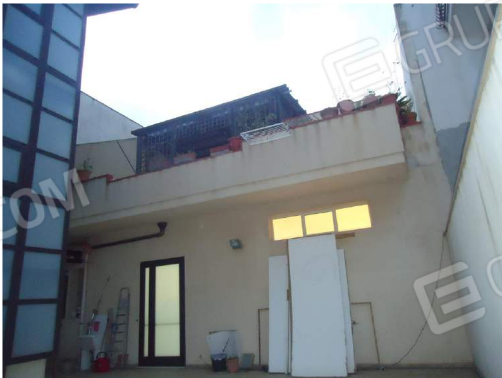
Foto n. 4 – Prospetto su cortile interno condominiale
