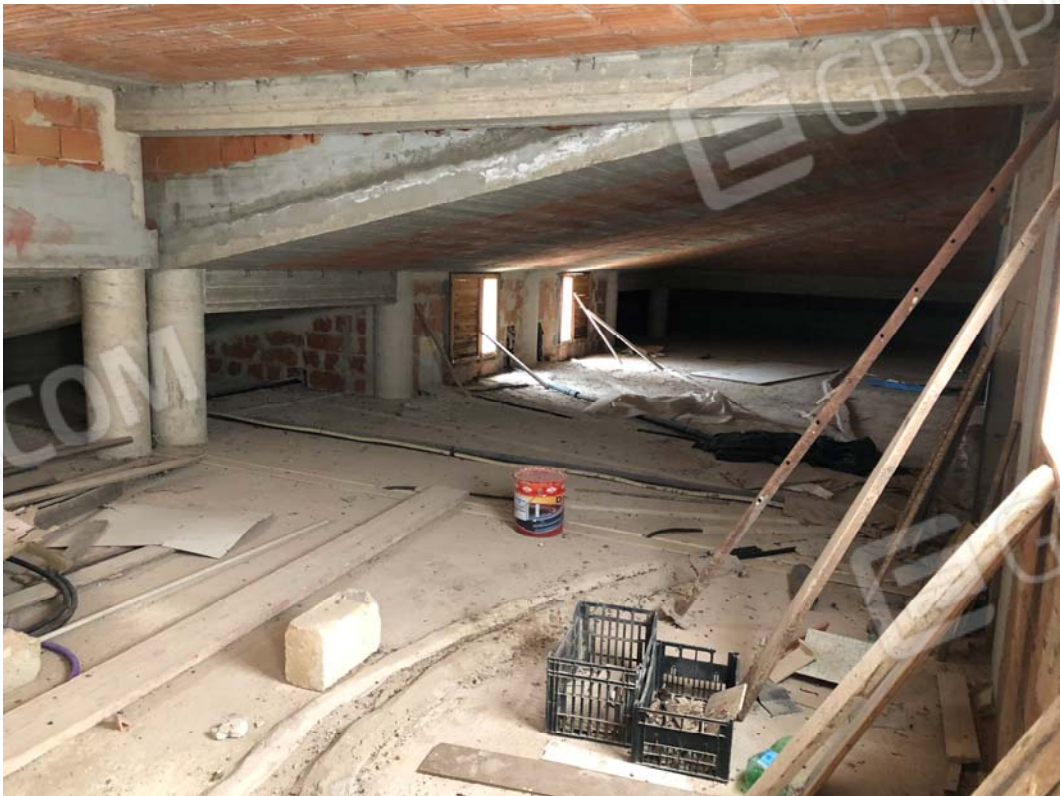
Foto n° 16 – vano tecnico sottotetto
