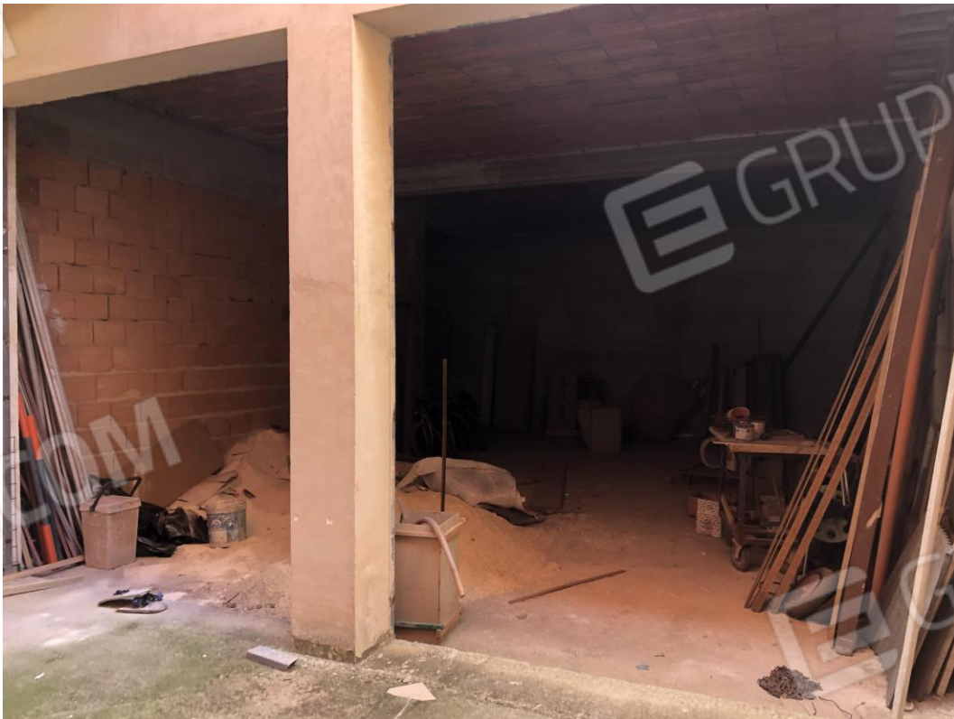
Foto n° 2 – Magazzino porzione sub 16
