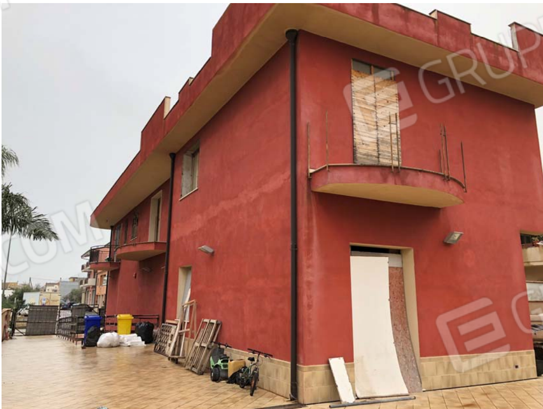
Foto n° 2 – Magazzino al piano terra
