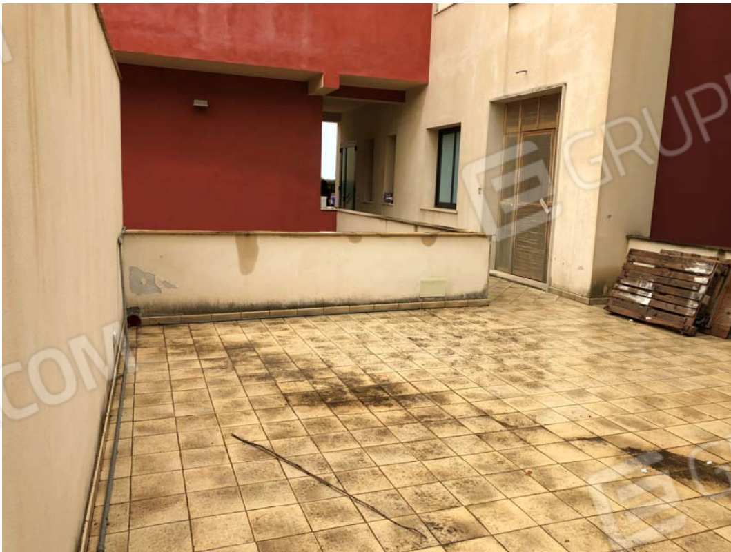
Foto n° 18 – Cortile esterno piano terra
