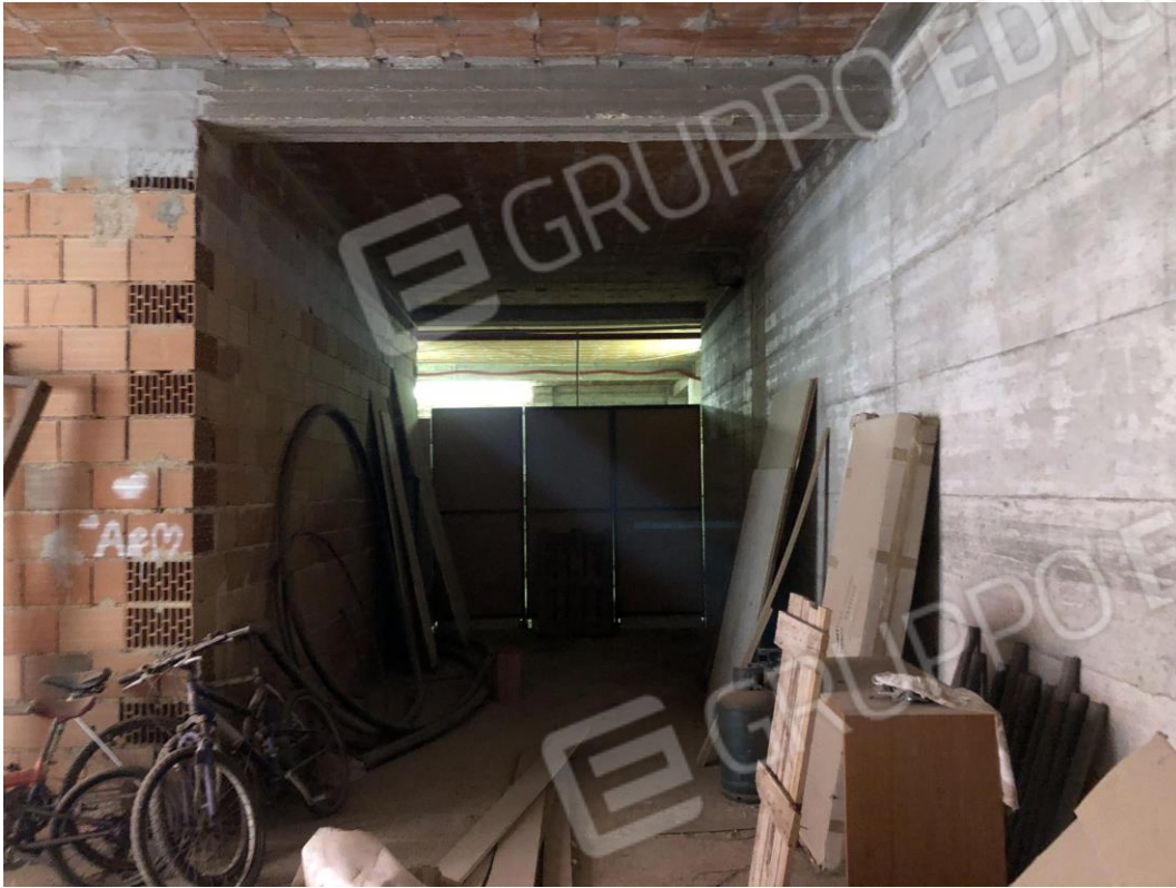
Foto n° 1 – Magazzino porzione sub 16
