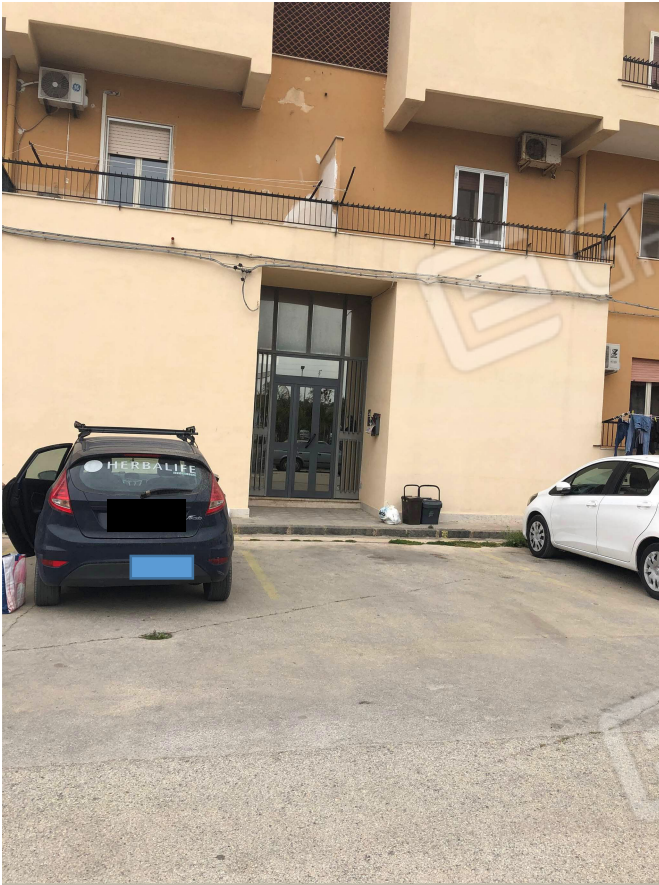
Foto 3: Vista del portone di ingresso comune.
