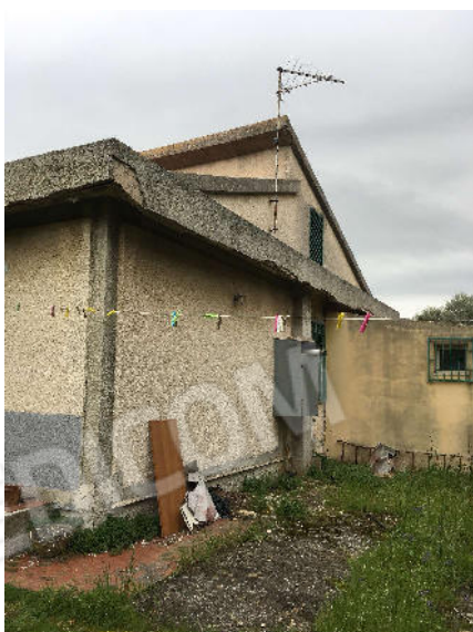
Facciata con orientamento a: nord - ovest
