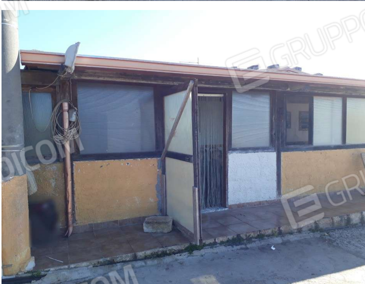
Foto 4 e 5 – Ingresso da veranda chiusa, lato ovest abitazione.
