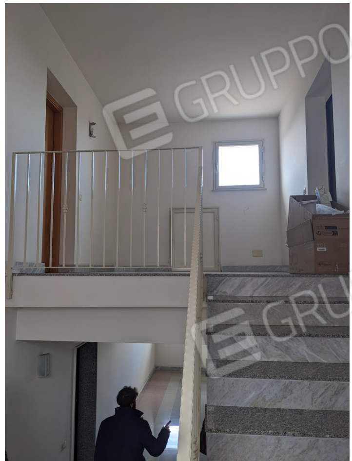
Scale di accesso al piano secondo / sottotetto non abitabile
