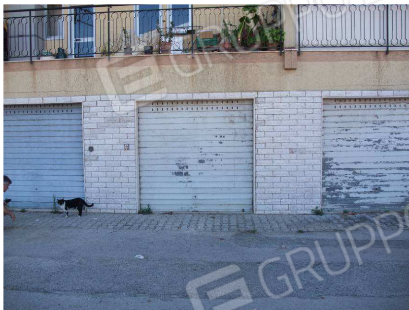
FOTO 9 – infisso esterno garage
