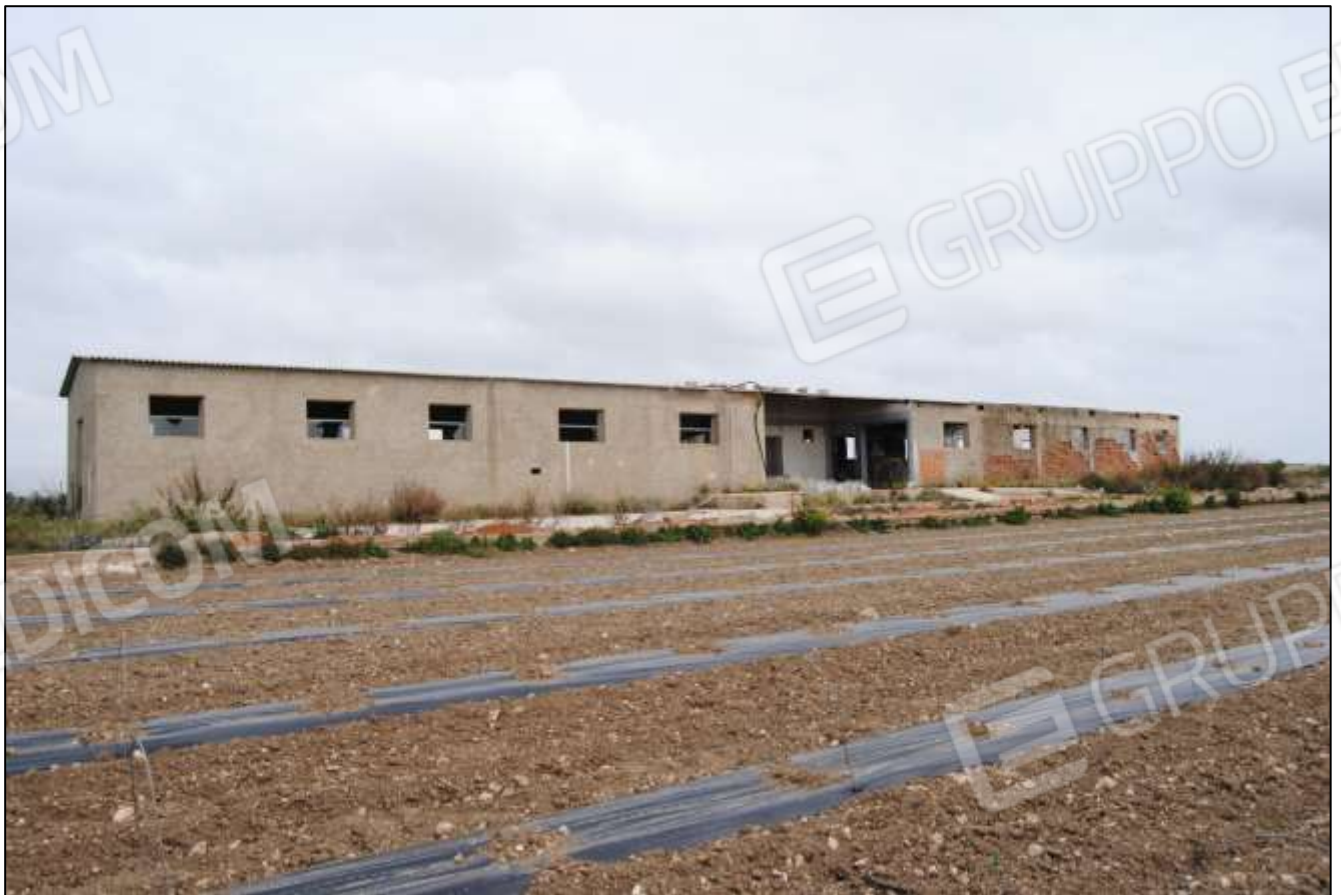
Foto n.14: Vista generale – Vista esterna Magazzino.
