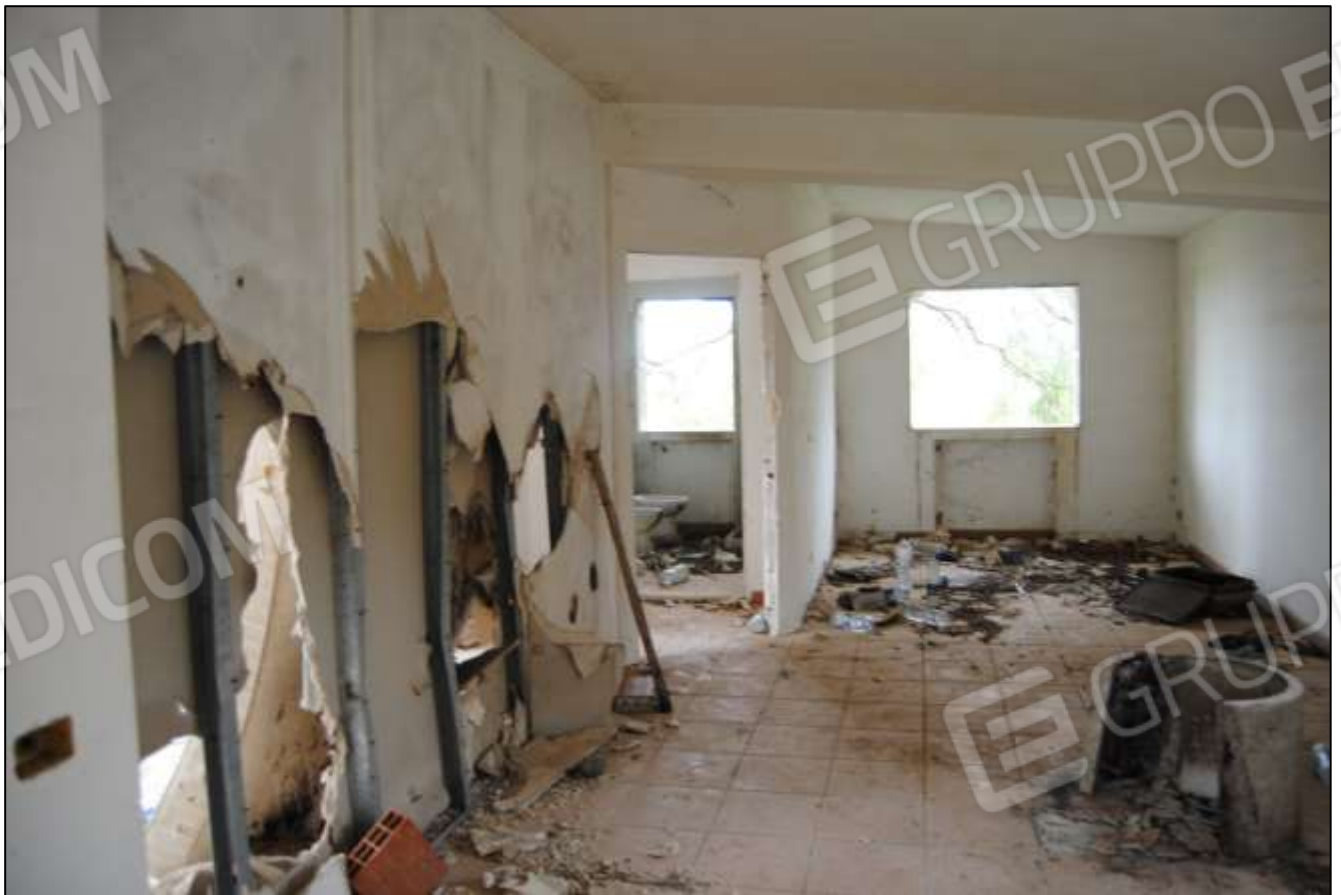
Foto n.12: Vista generale interna – Abitazione
