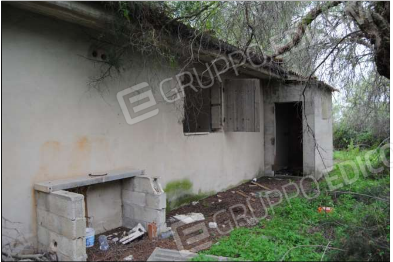
Foto n.9: Vista generale – Vista esterna Abitazione.
