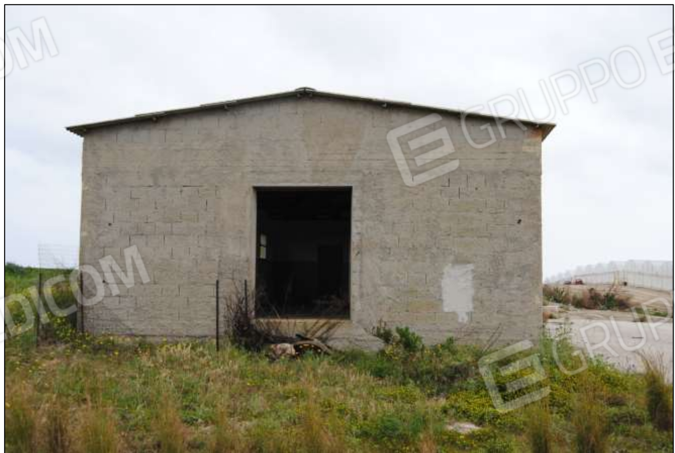
Foto n.18: Vista generale – Vista esterna Magazzino
