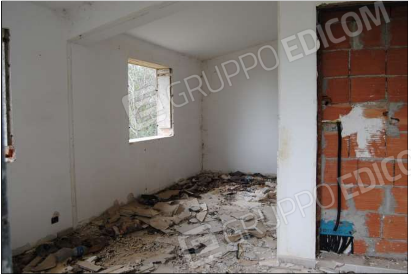
Foto n.11: Vista generale interna – Abitazione.
