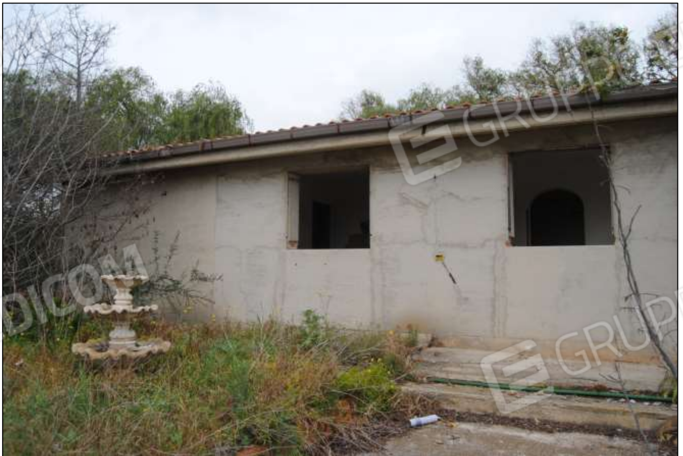
Foto n.6: Vista generale – Vista esterna Abitazione.
