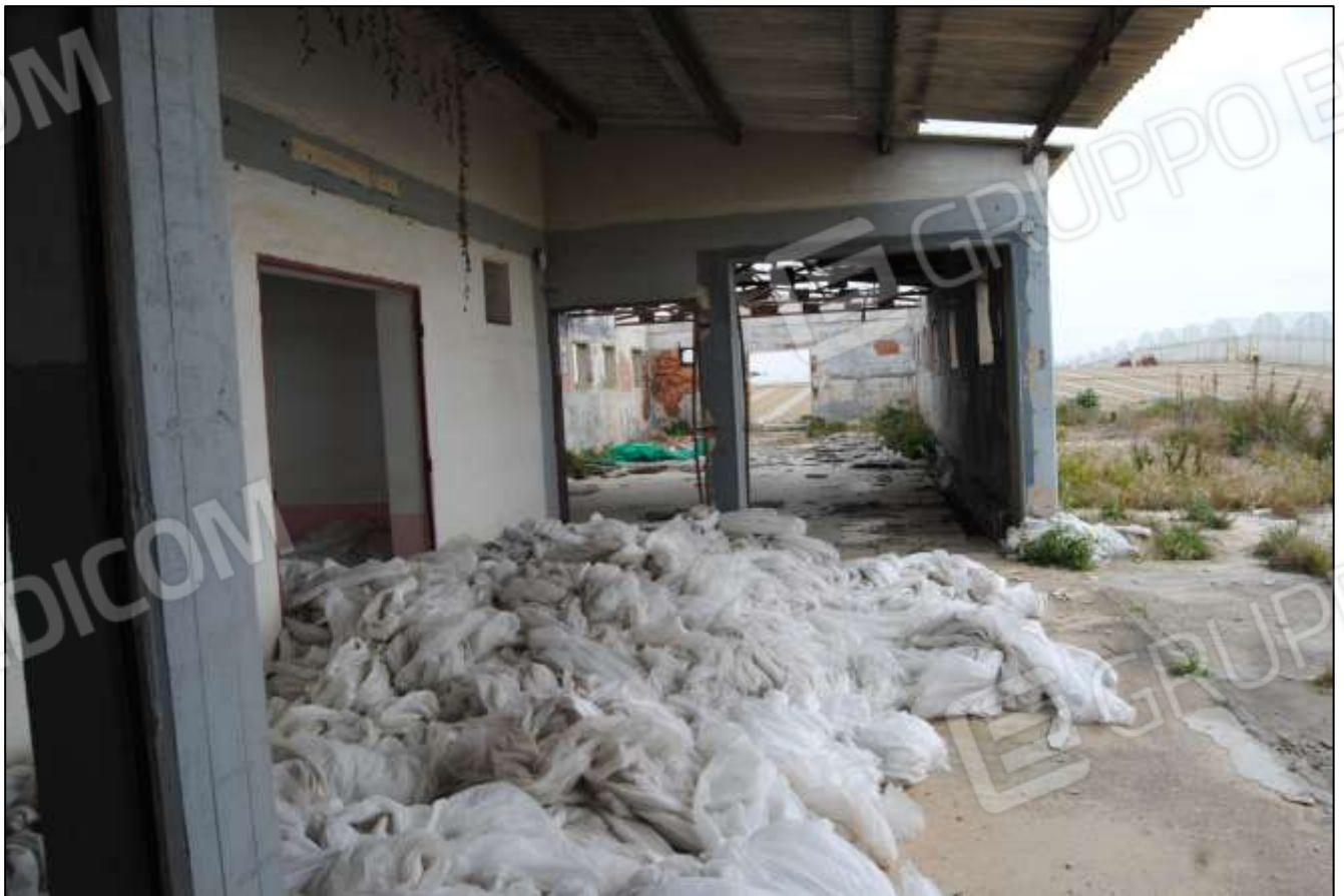
Foto n.20: Vista generale interna – Magazzino.
