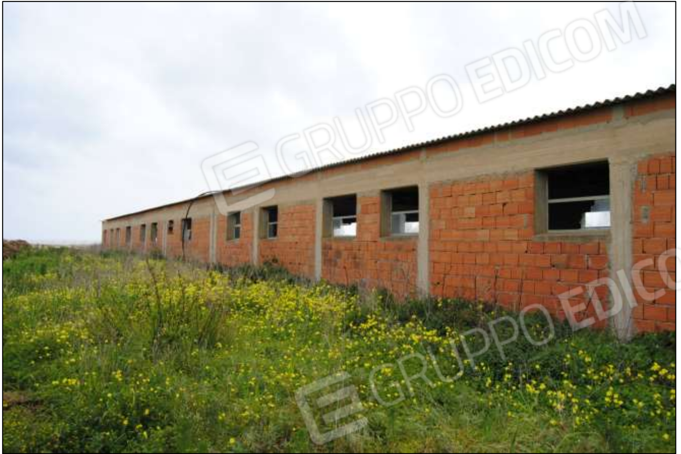
Foto n.15: Vista generale – Vista esterna Magazzino
