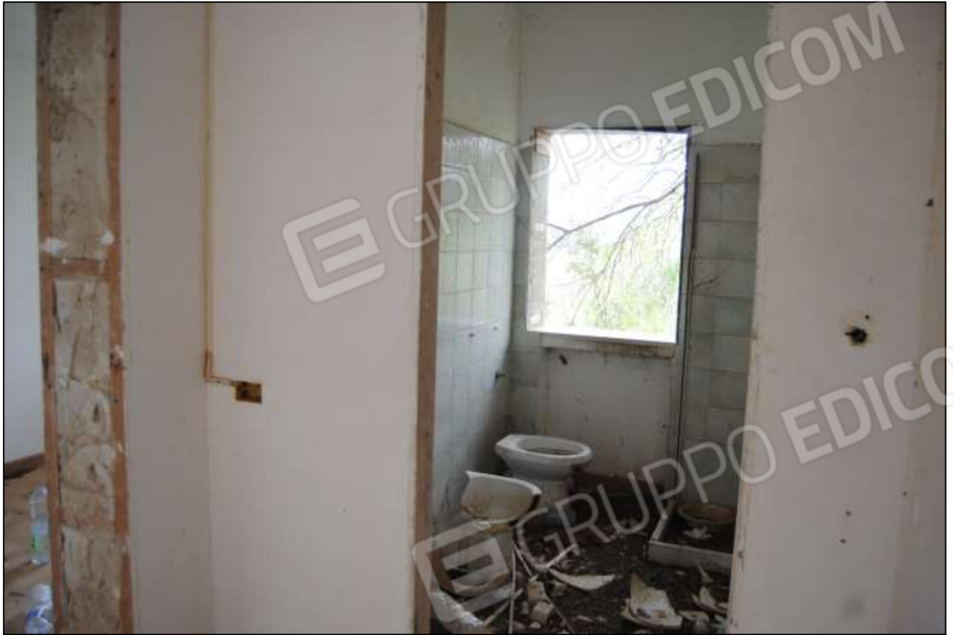
Foto n.13: Vista generale interna – Abitazione
