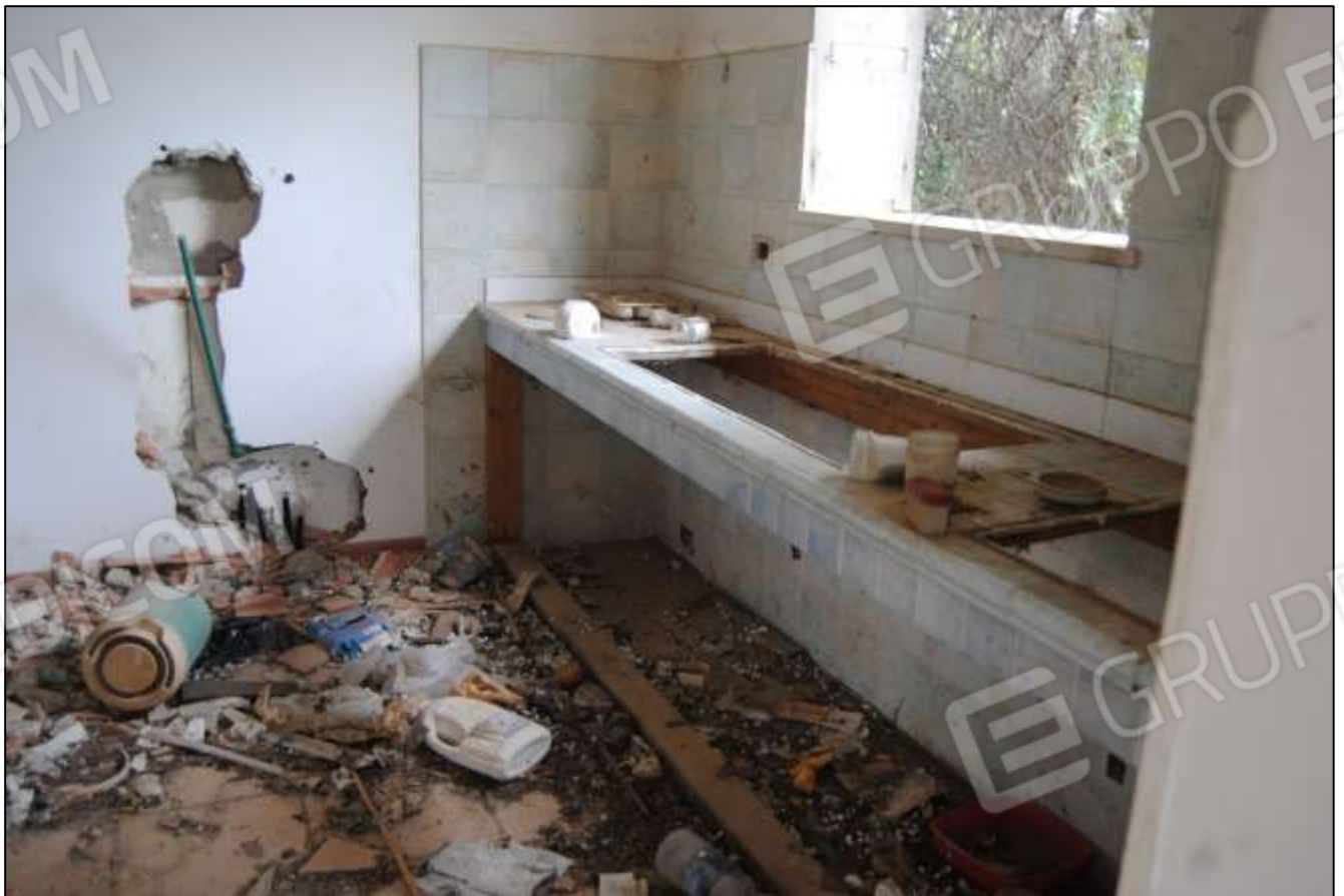
Foto n.10: Vista generale interna – Abitazione.
