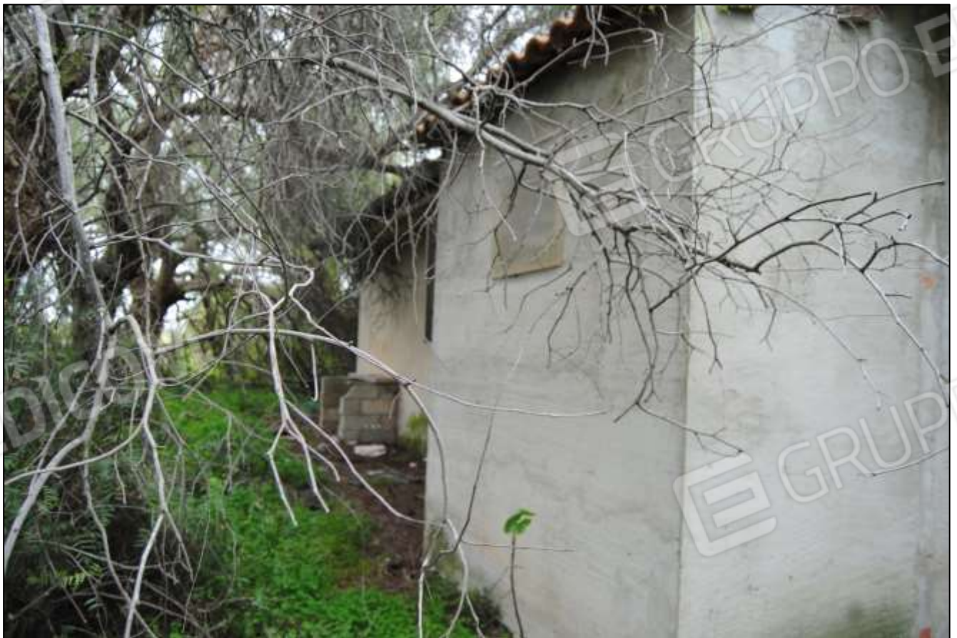
Foto n.8: Vista generale – Vista esterna Abitazione.
