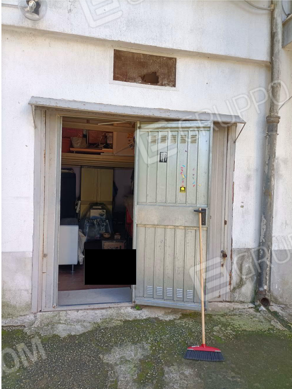
Foto 14. Vista esterna del garage.
