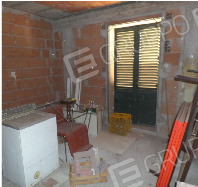
Foto n° 13. Piano 1°: Vano 3/Cucina
