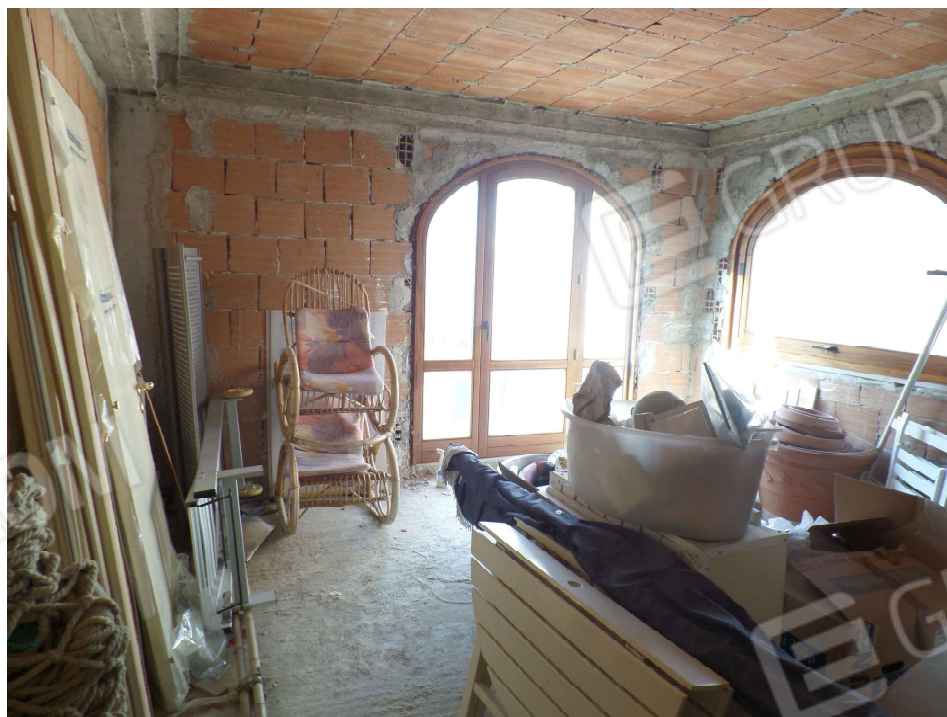
Foto n° 16. Piano 1°: Vano 4/Soggiorno/Pranzo
