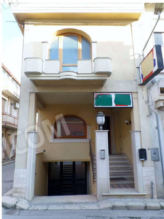
Foto n° 2. Prospetto: Via D. Alighieri n° 122
