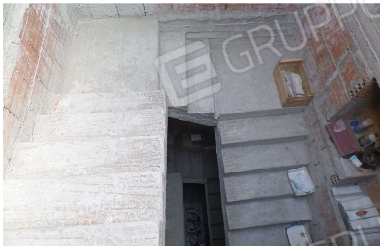
Foto n° 21. Piano 2°: Vano scala
