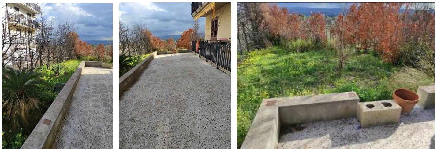
Foto 38,39,40,41,42,43. Balcone 2 e Terreno di pertinenza lato Est
