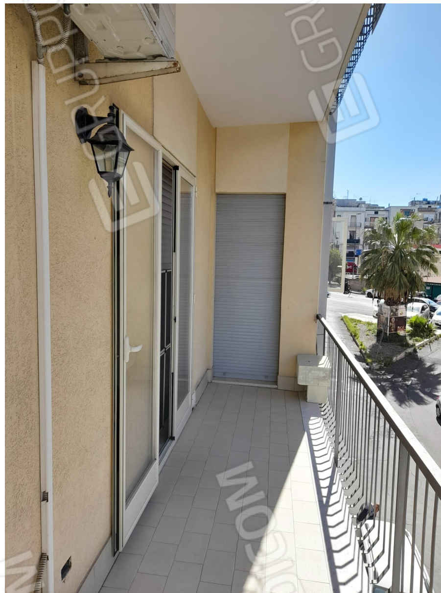
Foto n°12 - Vista del balcone su via Gaeta
