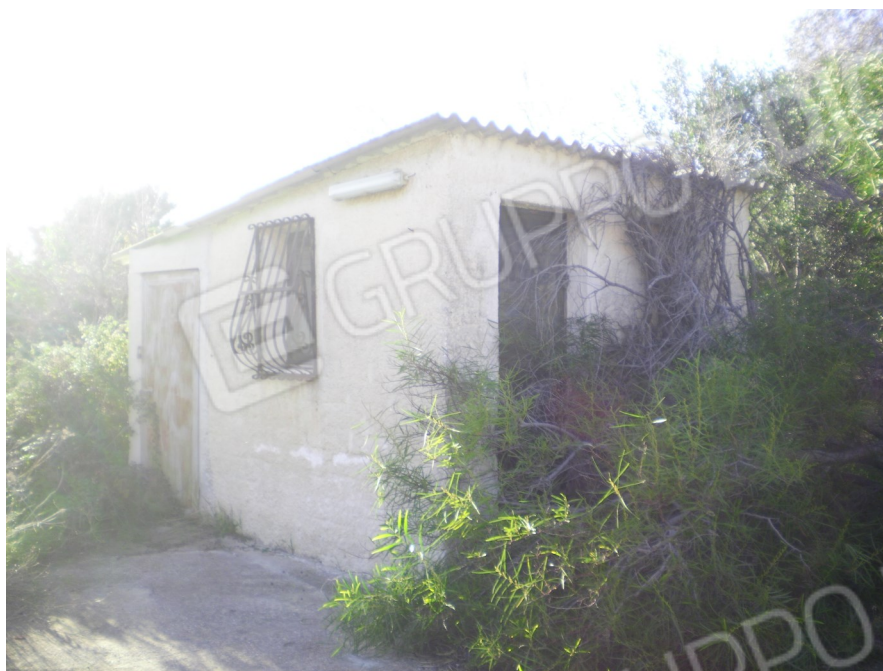
Foto 05: Vista locale forno
