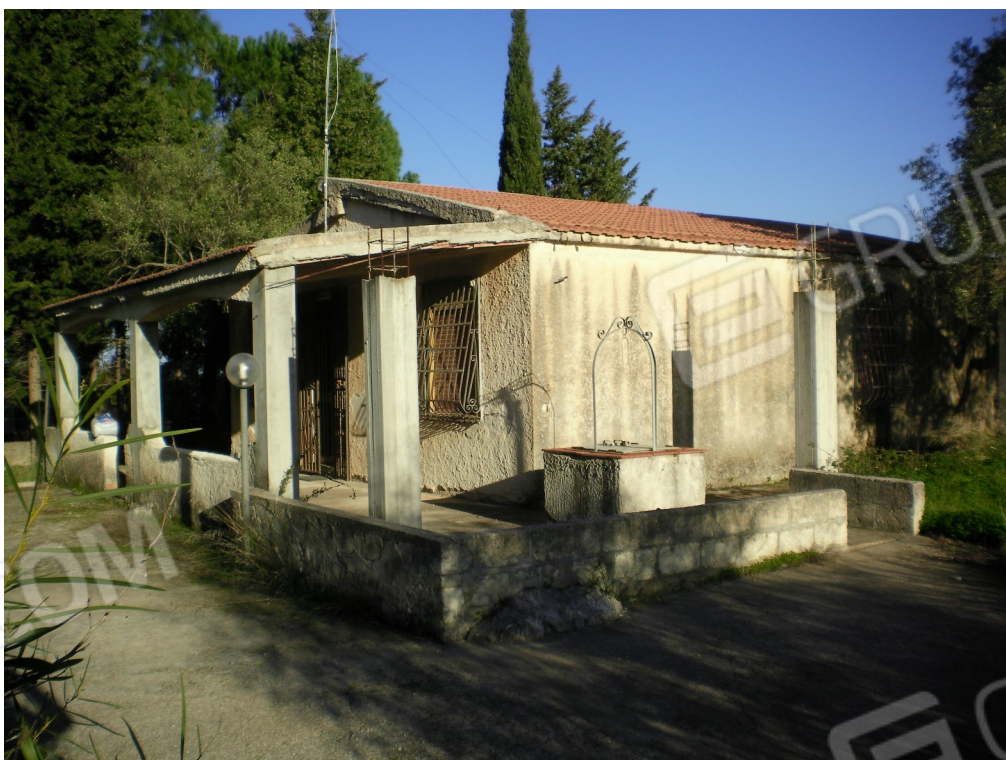
Foto 02: Vista prospetto Sud- Ovest
