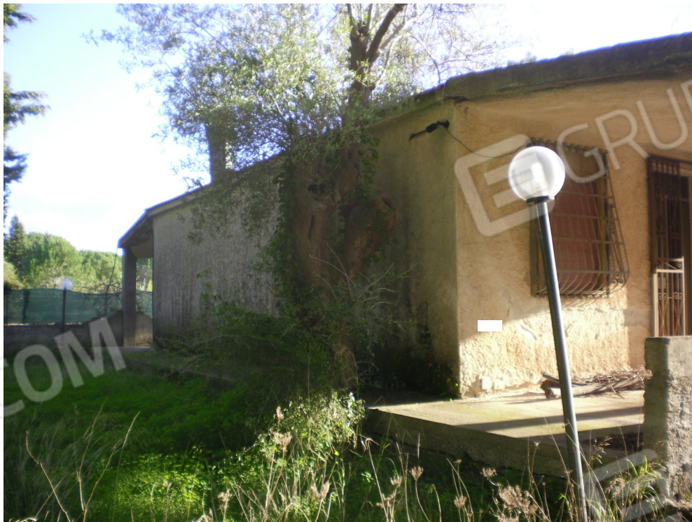
Foto 04: Vista prospetto Nord
