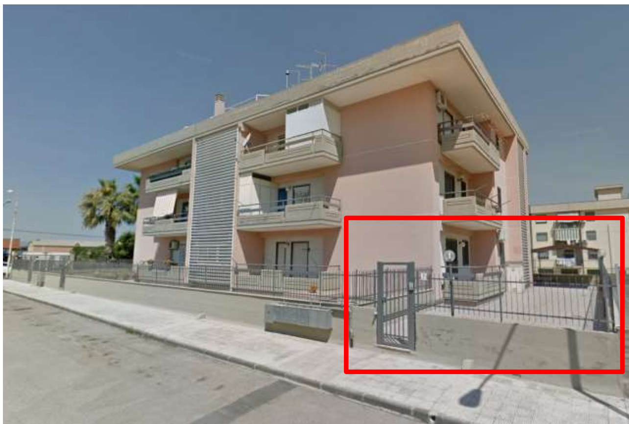
Foto 5 – Immobile “1A” – Veduta prospettica su via G. Di Mari
