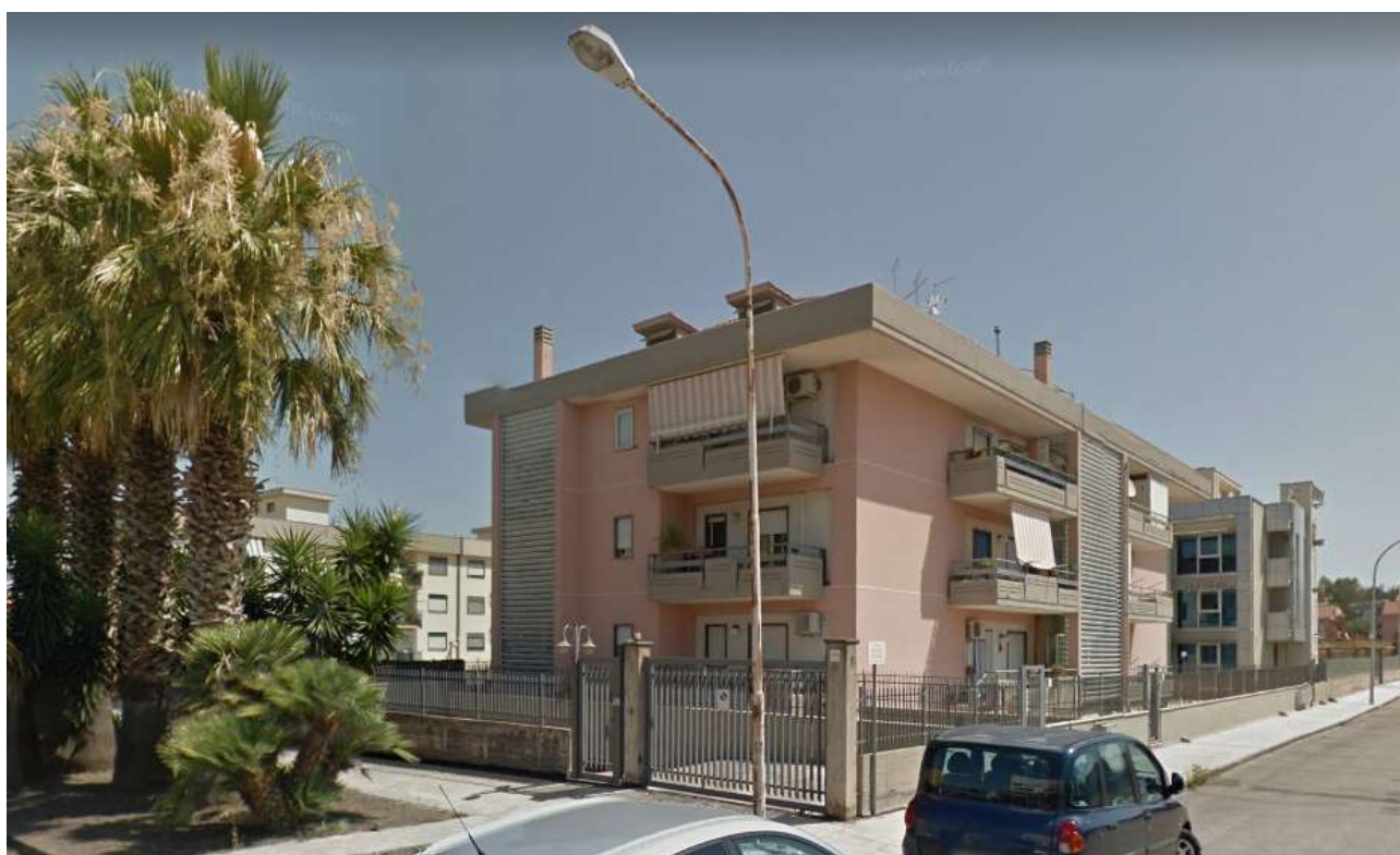
Foto 4 – Immobile “1A” – Veduta prospettica su via G. Di Mari
