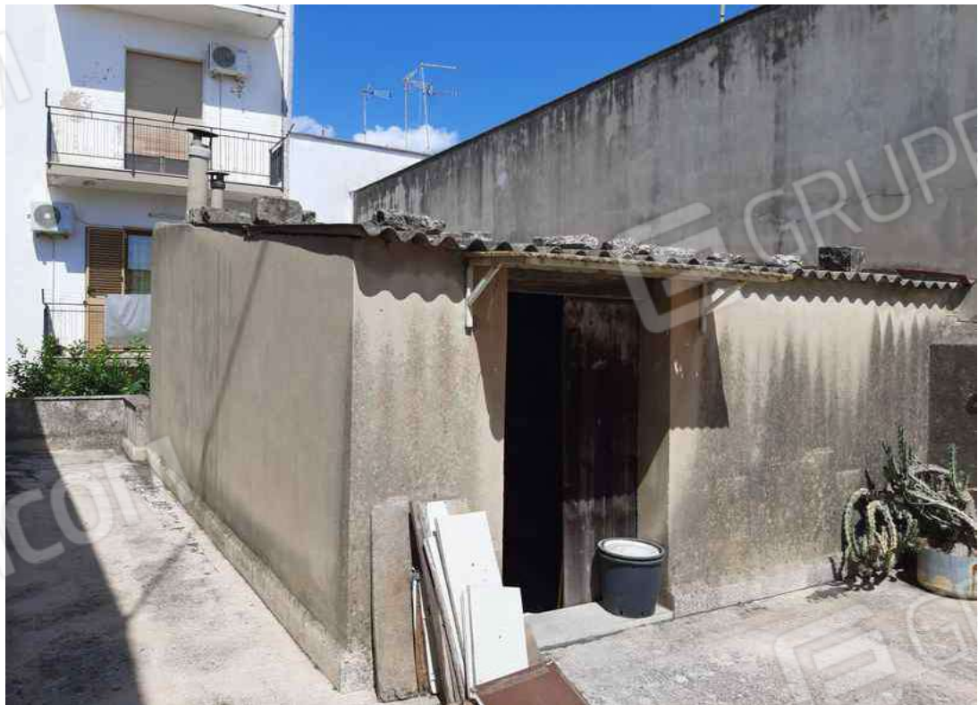
G.33 – Veduta del Terrazzo lato Ovest – altra veduta del locale forno.
