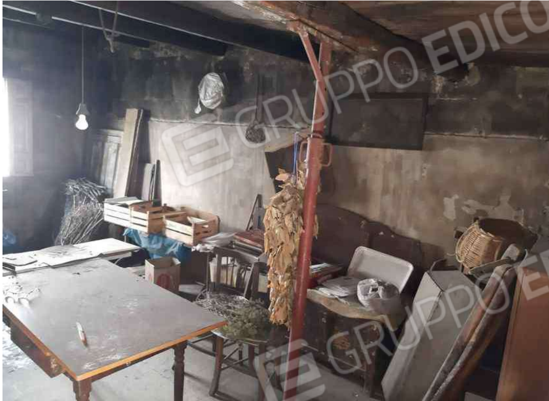
G.36 – altra veduta del locale forno.
