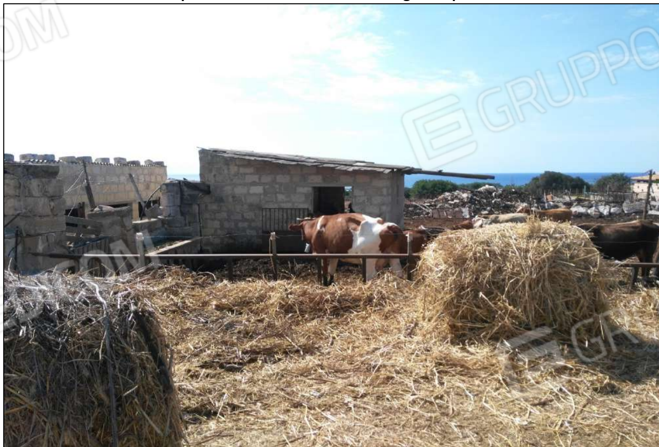
Foto 46 - Vista panoramica esterna immobile foglio 35 p.la 1492 sub 1-2-3
