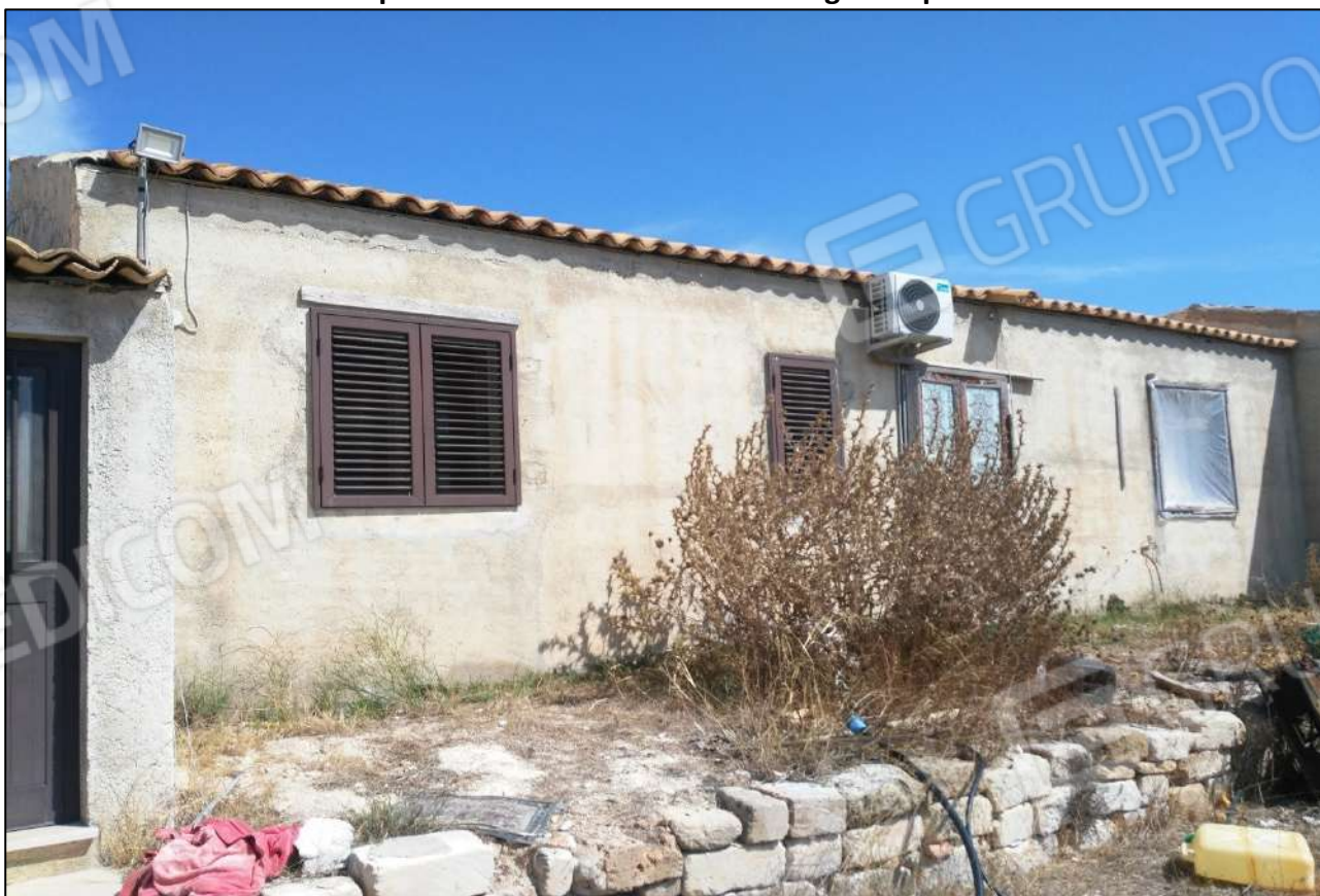
Foto 18 Vista panoramica esterna immobile foglio 35 p.lla 1195 sub 3 e 4
