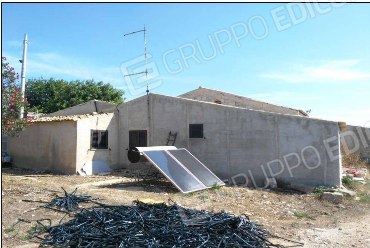
Foto 17 Vista panoramica esterna immobile foglio 35 p.lla 1195 sub 4
