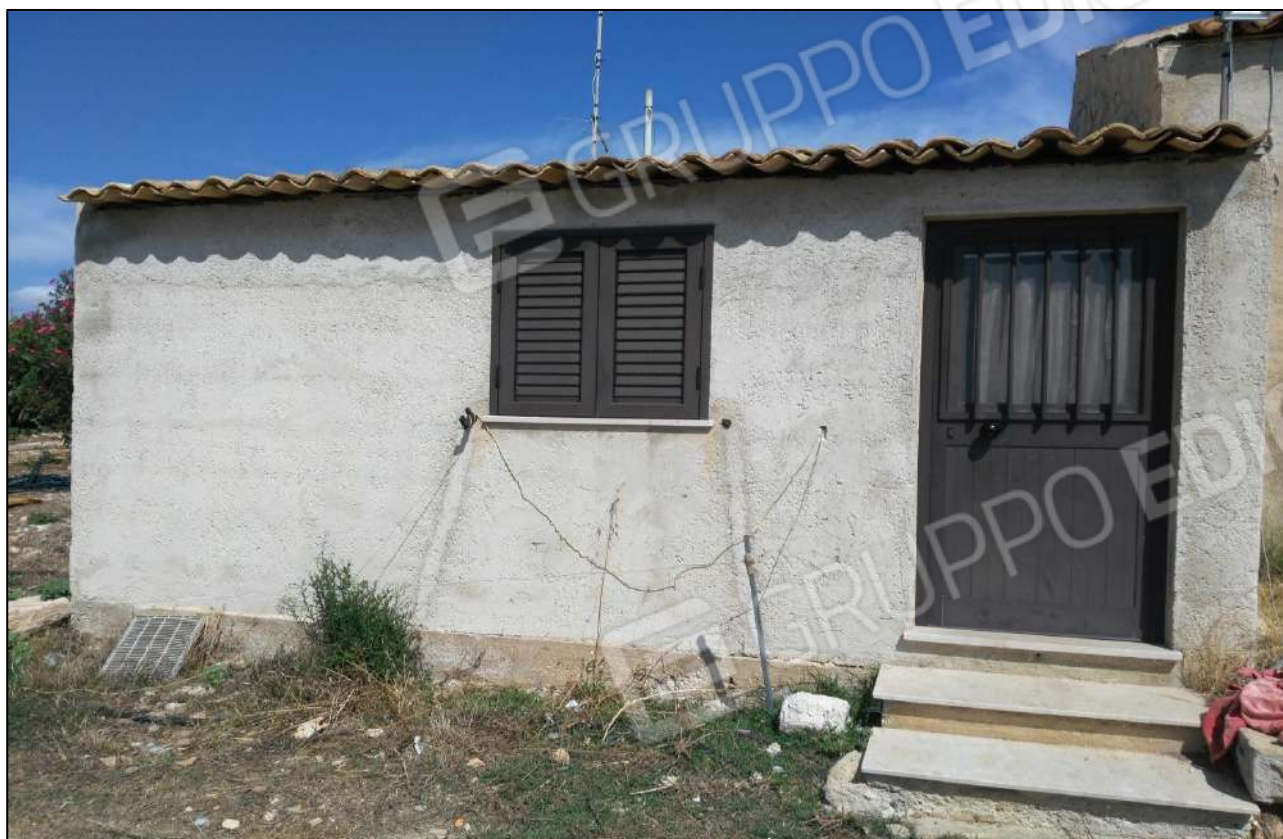
Foto 19 - Vista panoramica esterna immobile foglio 35 p.lla 1195 sub 4
