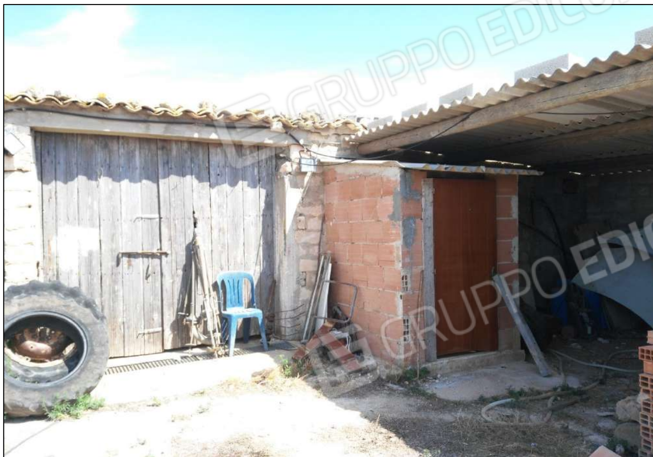
Foto 47 - Vista panoramica esterna immobile foglio 35 p.IIa 1195 sub 2
