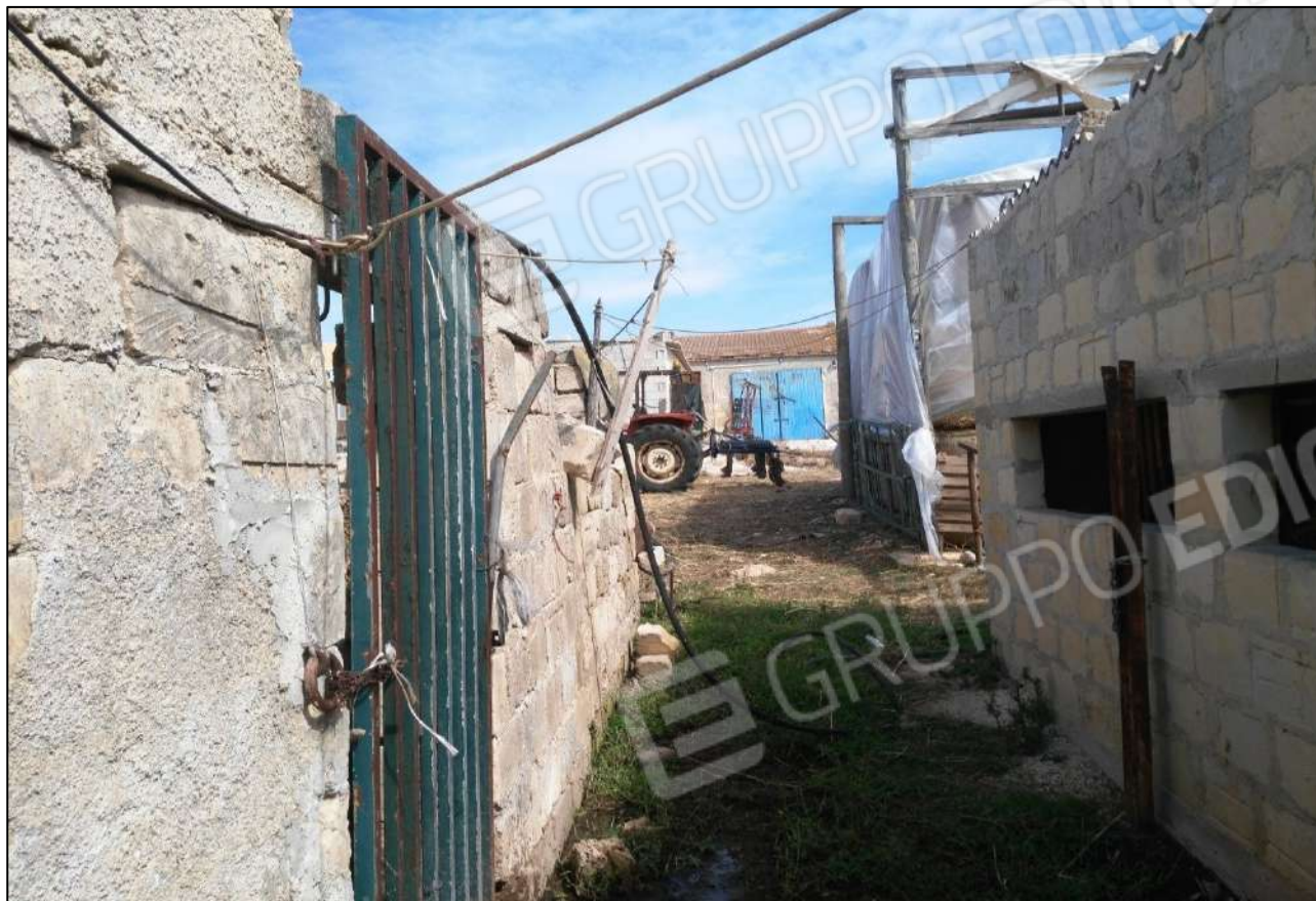
Foto 43 - Vista panoramica esterna immobile foglio 35 p.IIa 1492 sub 1-2-3
