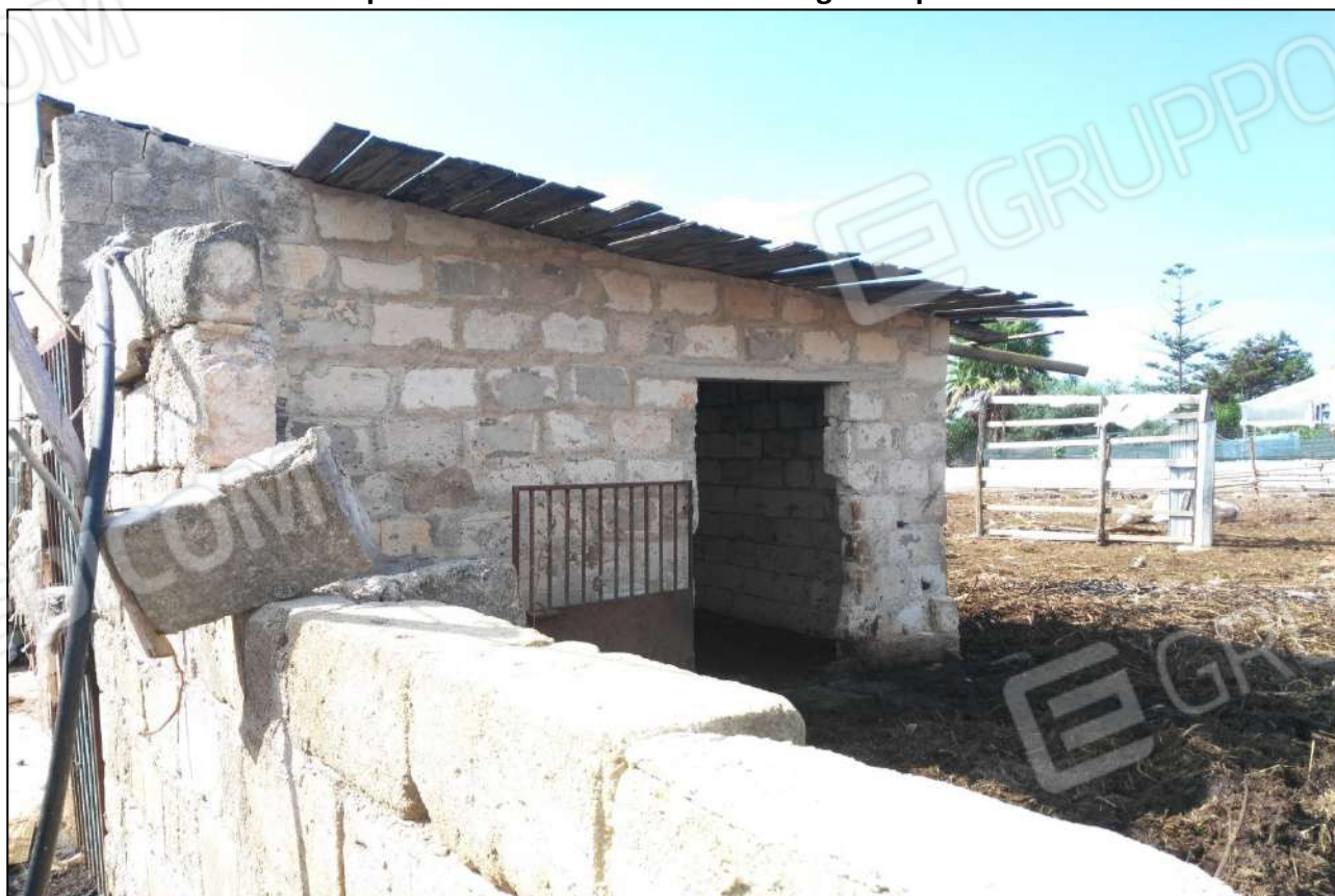
Foto 44 - Vista panoramica esterna immobile foglio 35 p.IIa 1492 sub 1-2-3
