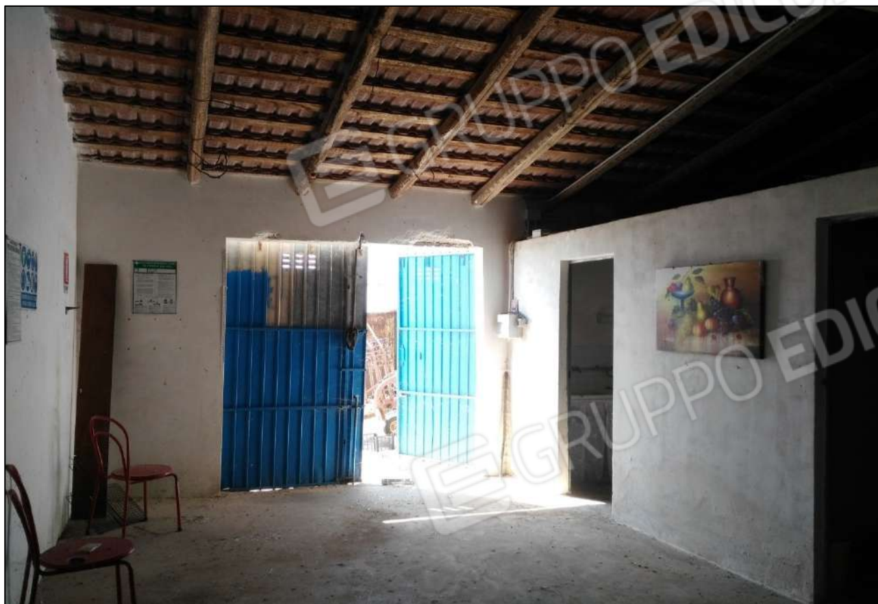
Foto 49 - Vista panoramica interna immobile foglio 35 p.la 1195 sub 1
