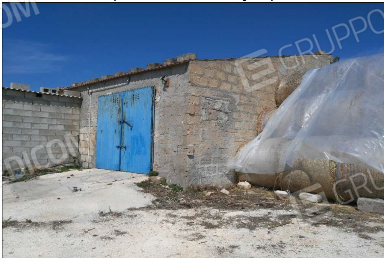
Foto 50 - Vista panoramica esterna immobile foglio 35 p.la 1195 sub 1
