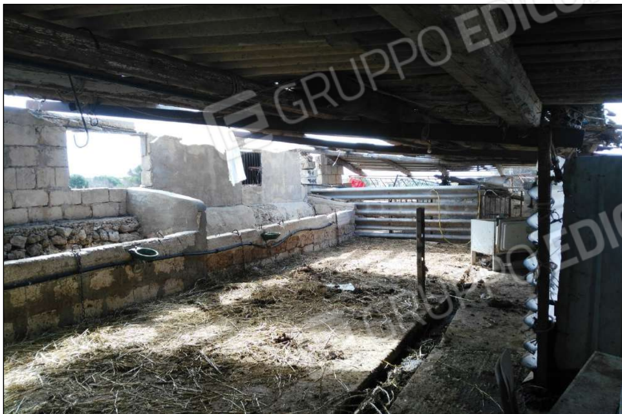
Foto 41 - Vista panoramica interna immobile foglio 35 p.la 1492 sub 1-2-3
