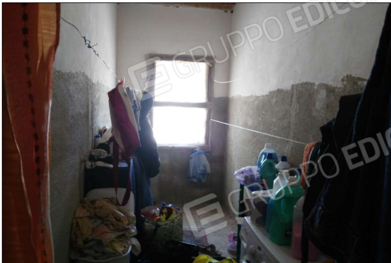
Foto 31 - Vista panoramica interna immobile foglio 35 p.IIa 1195 sub 3
