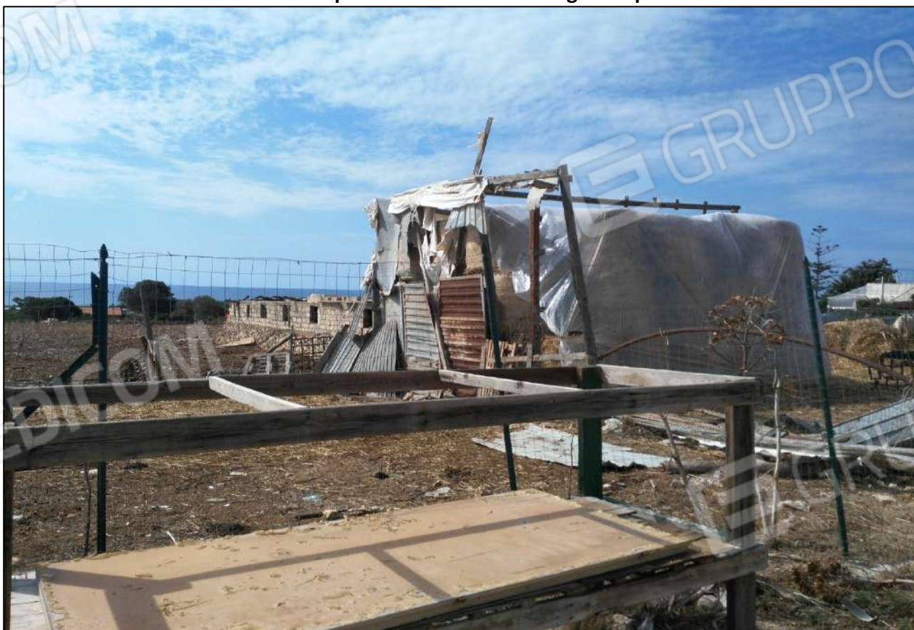
Foto 10 - Vista panoramica immobile foglio 35 p.IIa 721
