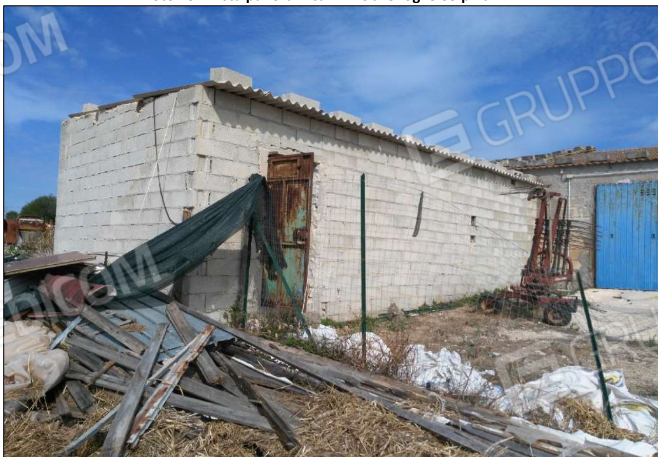
Foto 14 - Vista panoramica immobile foglio 35 p.IIa 721
