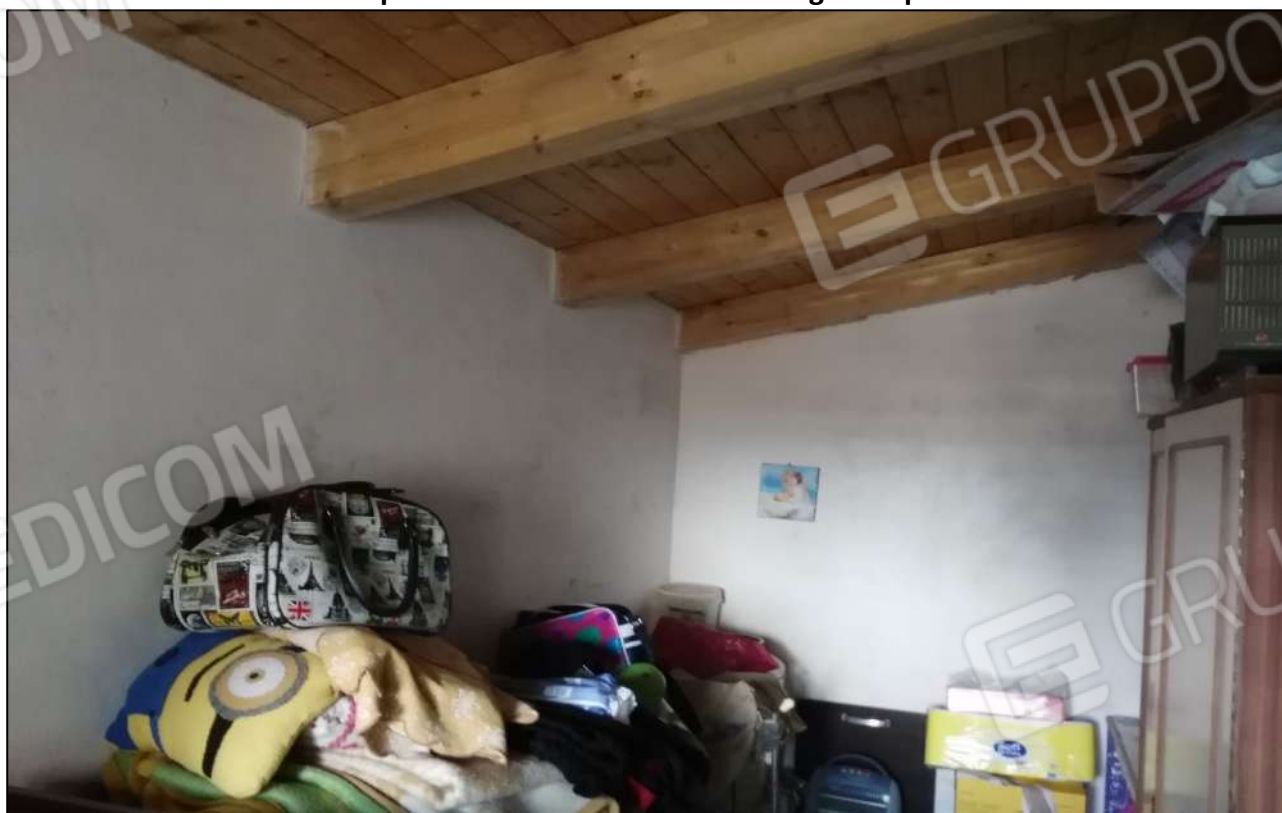
Foto 24 - Vista panoramica interna immobile foglio 35 p.IIa 1195 sub 4
