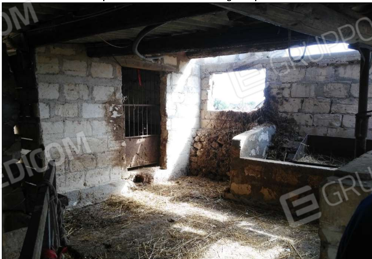
Foto 42 - Vista panoramica interna immobile foglio 35 p.la 1492 sub 1-2-3
