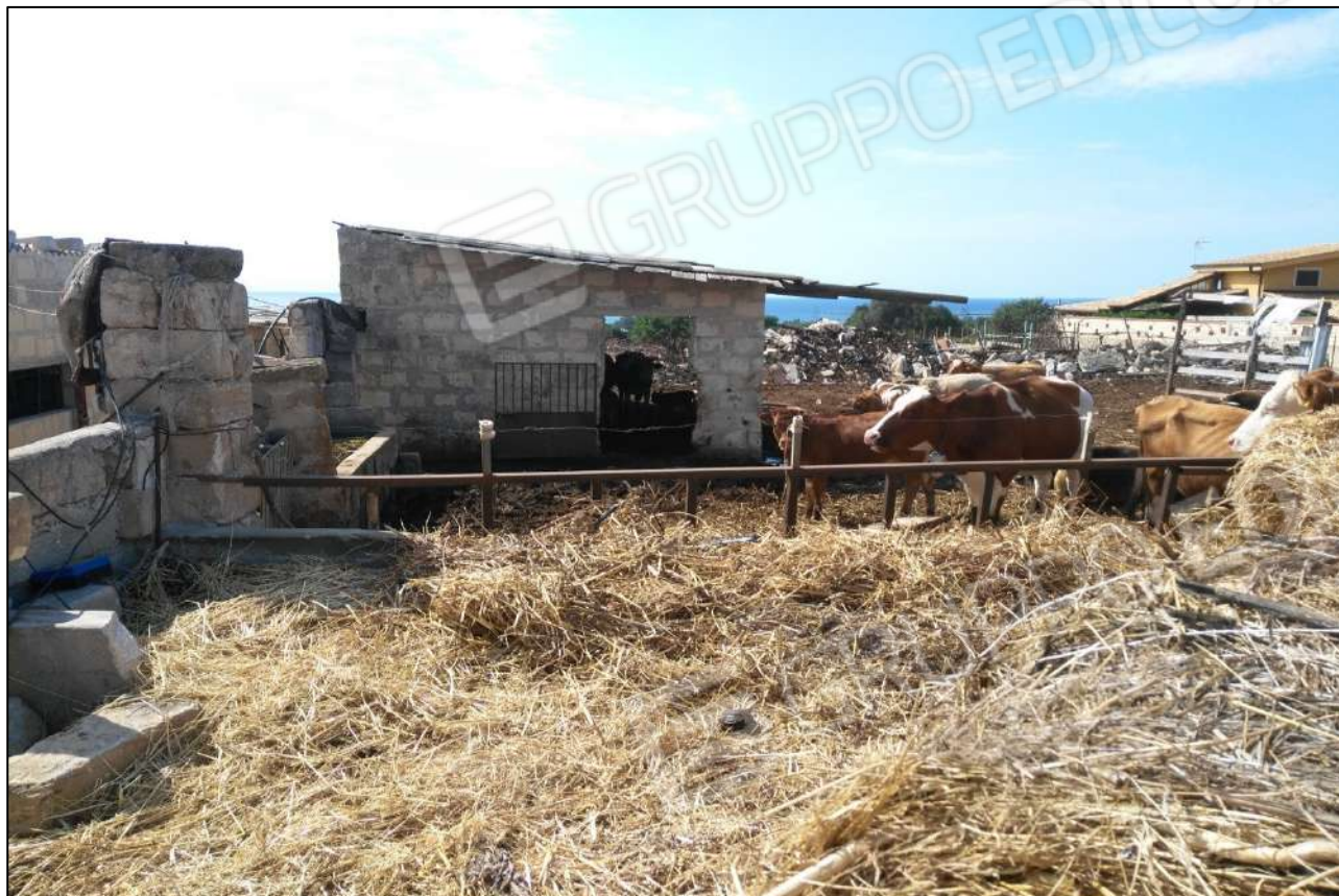
Foto 45 - Vista panoramica esterna immobile foglio 35 p.la 1492 sub 1-2-3
