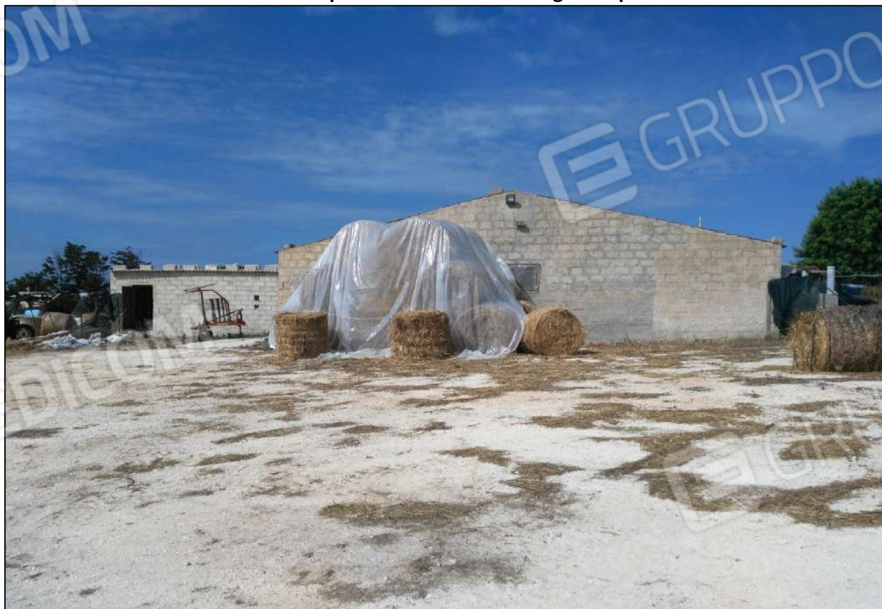
Foto 12 - Vista panoramica immobile foglio 35 p.IIa 721
