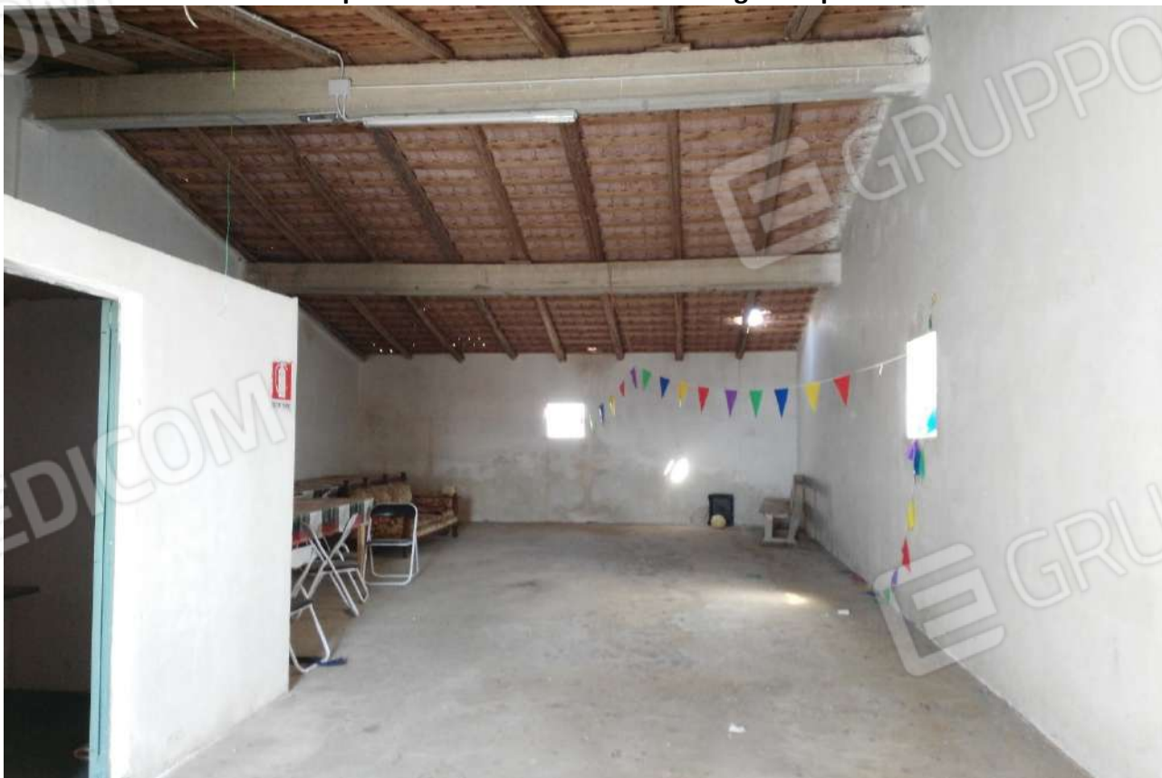
Foto 48 - Vista panoramica interna immobile foglio 35 p.IIa 1195 sub 1
