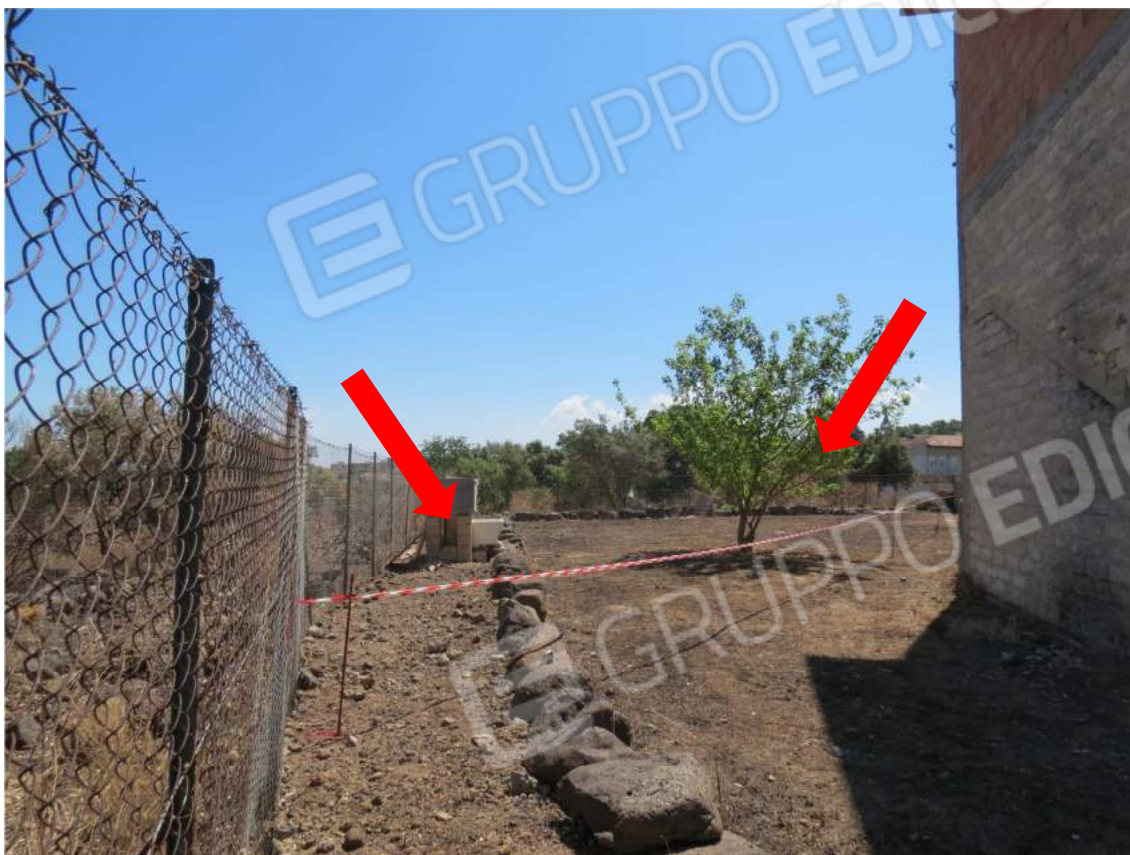
Foto n. 20: Corte del bene A.2, le frecce indicano la zona di sconfinamento di proprietà di terzi
