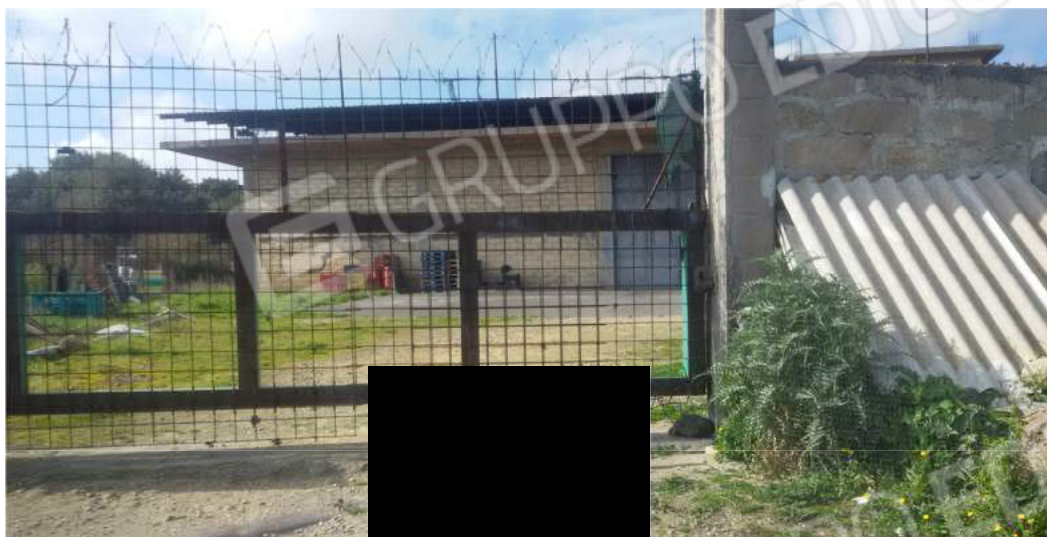
Fono n.1: Ingresso d'ingresso al Fabbricato (bene A.2)
