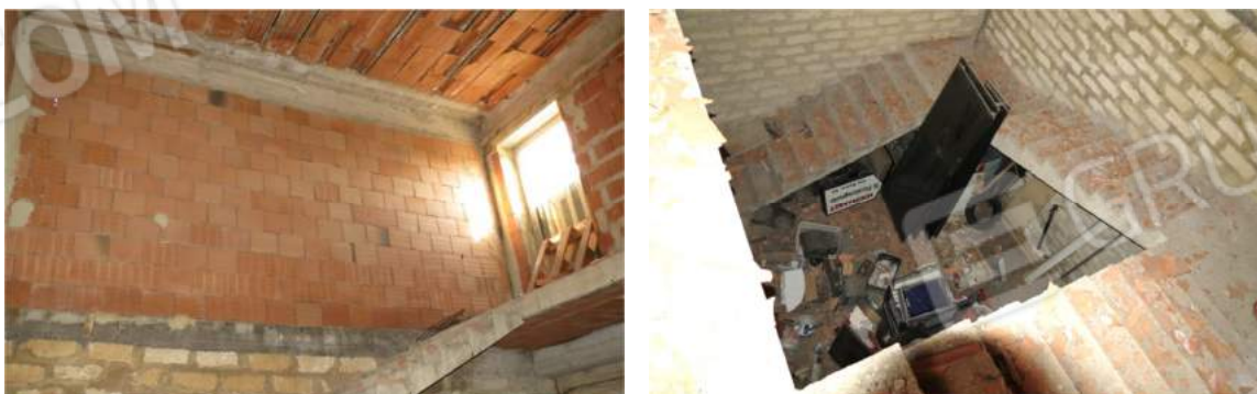
Foto n. 16-17: Bene A.2 – Vano scala
