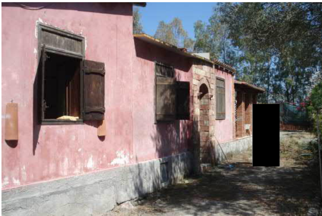
5_il lato est del fabbricato principale
