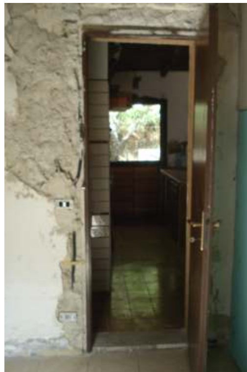
20_B2 | camera, vista verso il lato ovest
