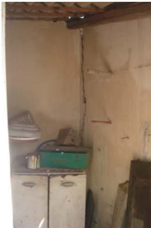
34_E | locale unico
