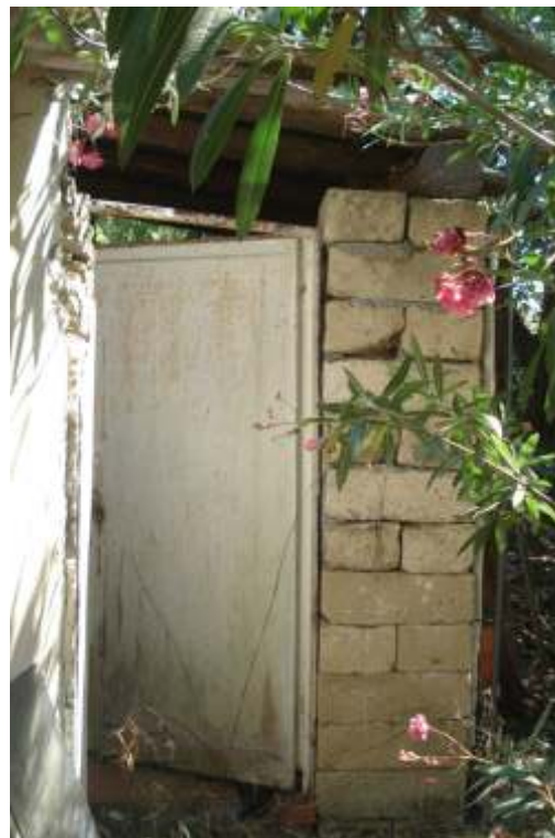
32_E | locale unico
