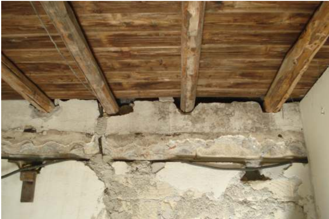
21_B2 | camera, vista della copertura
