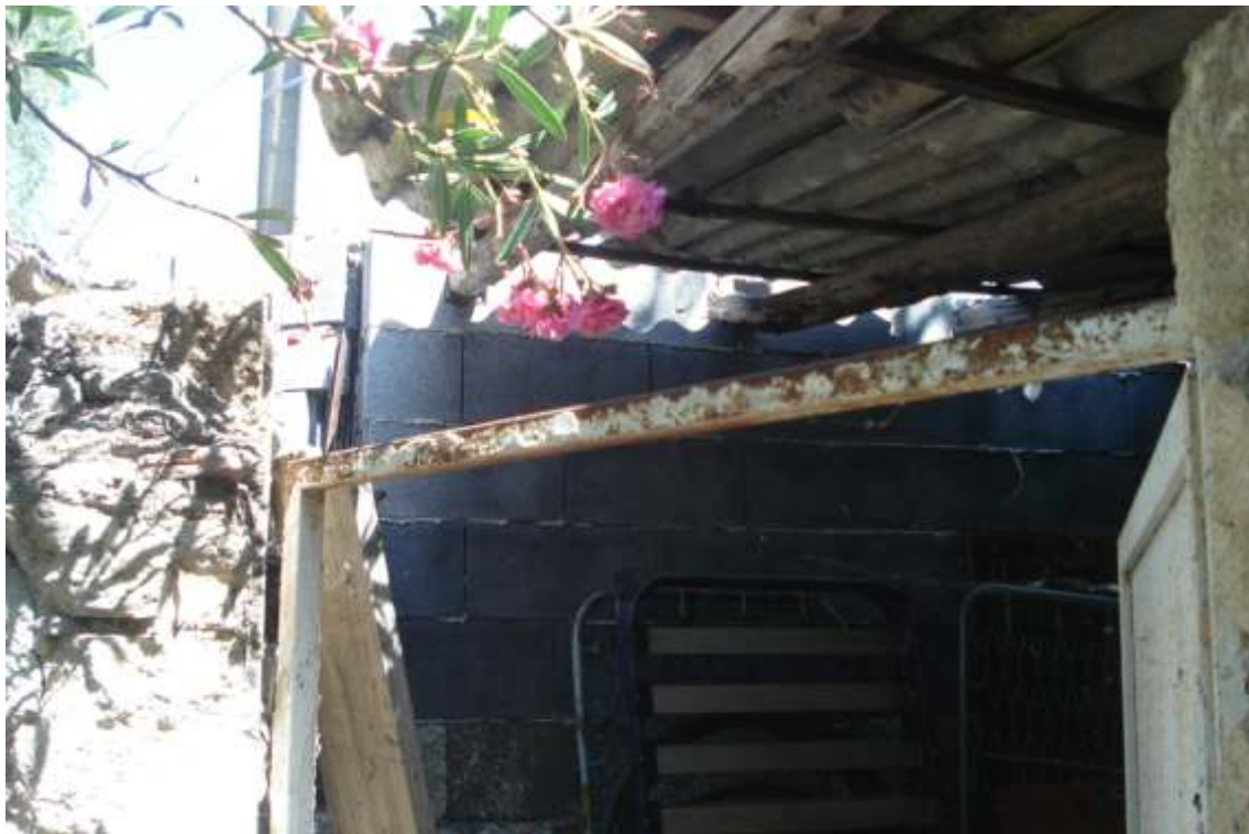
33_E | locale unico
