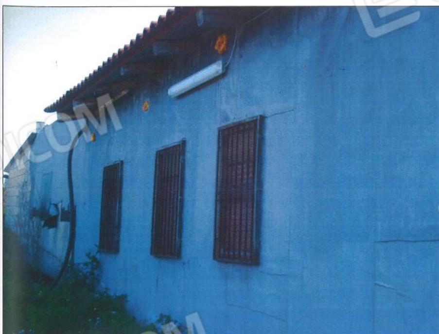
Prospetto nord fabbricato.
