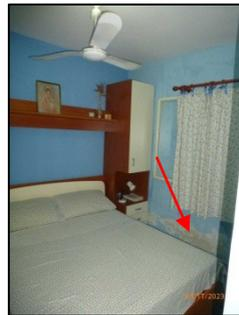
Foto 9-10 Camera di 9,75 mq (Si noti l'umidità di risalita)
