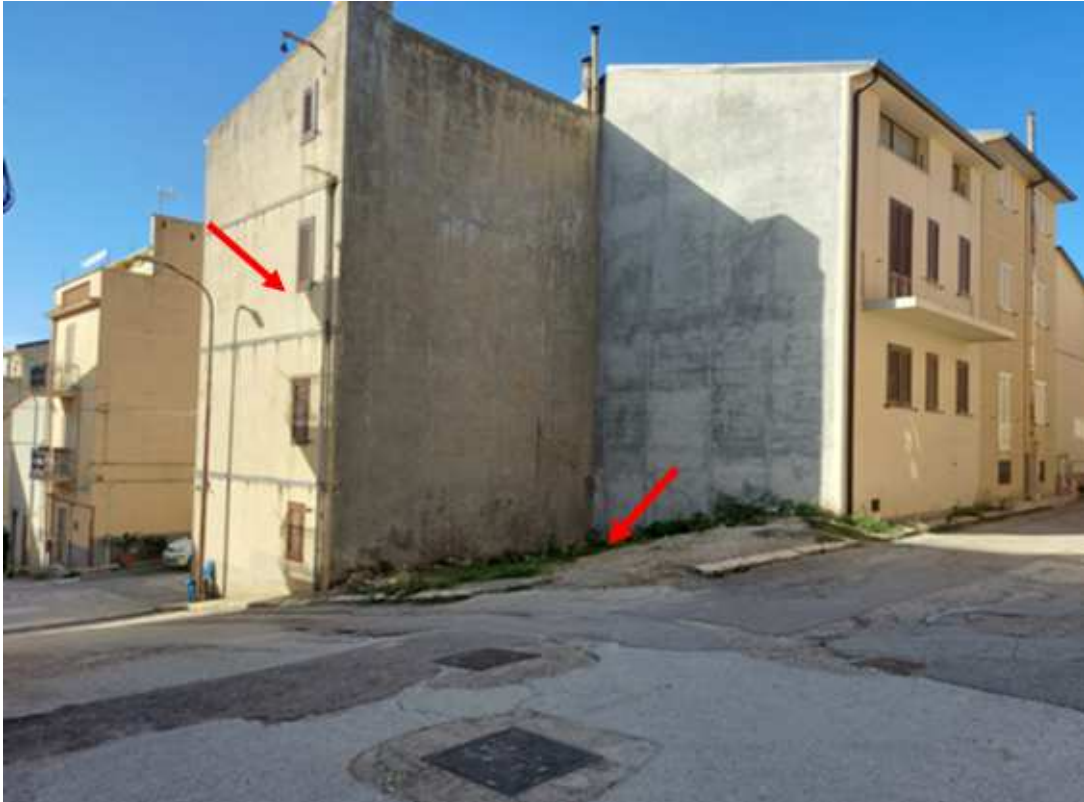
Foto 1– Via Umbria angolo Via S. Vincenzo – Indicazione dell'area edificabile e dell'immobile confinante oggetto di pignoramento LOTTO 1
