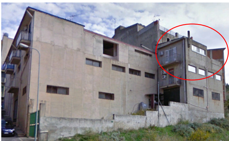
Foto 2 Google Earth (retro prospetto)
