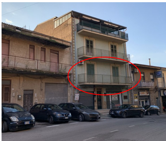
Foto 1 (prospetto principale su Via Roma)
