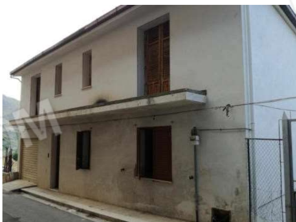
Il prospetto principale ad Est sulla Via Serra Molinazzo
