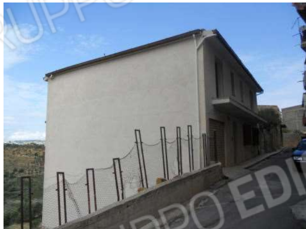
Via Serra Molinazzo in direzione del centro abitato e prospetto a Sud del fabbricato
