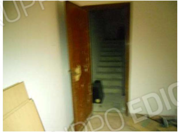
Locale di accesso comune al corpo scala
