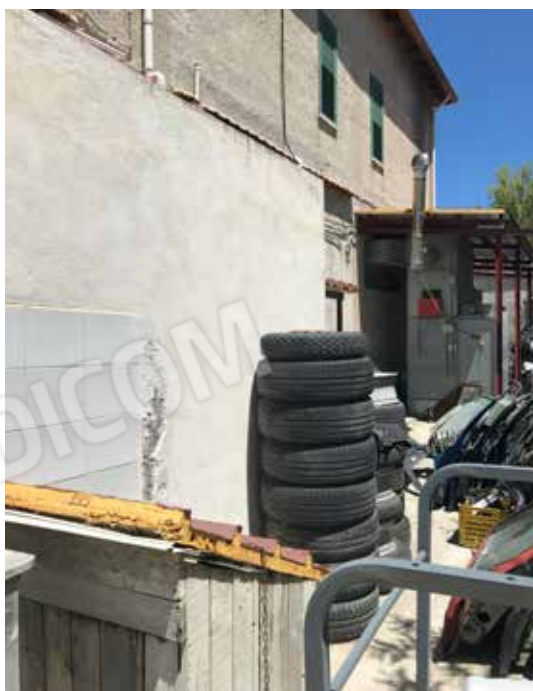
Foto 15. Area esterna di pertinenza del Locale adibito per l'attività di auto-carrozzeria.
