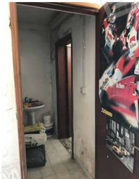
Foto 9. Locale adibito per l'attività di auto-carrozzeria, disimpegno.
