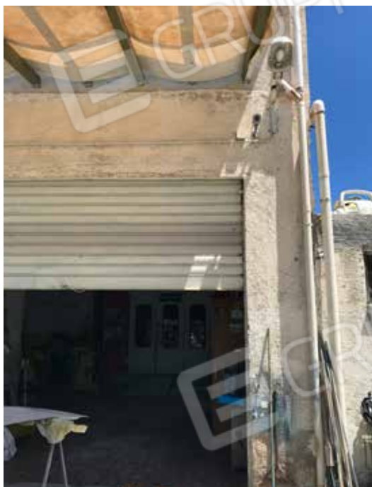
Foto 4. Ingresso al locale adibito per l'attività di auto-carrozzeria.
