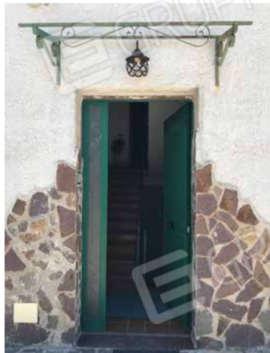
Foto 8. Ingresso all'unità immobiliare posta al piano primo.
