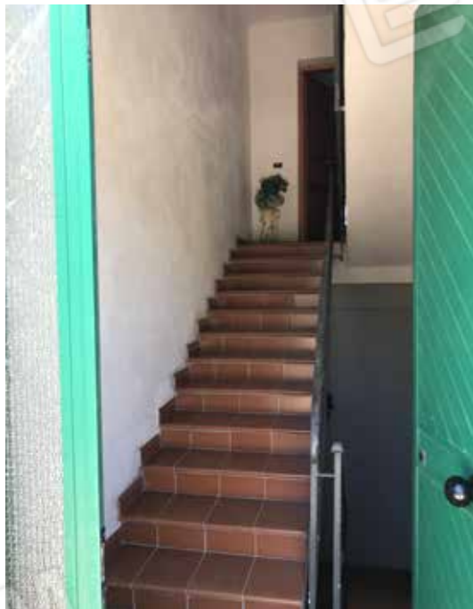
Foto 9. Ingresso all'unità immobiliare posta al piano primo.
