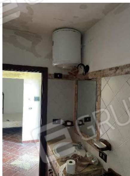
Vano wc piano terra
