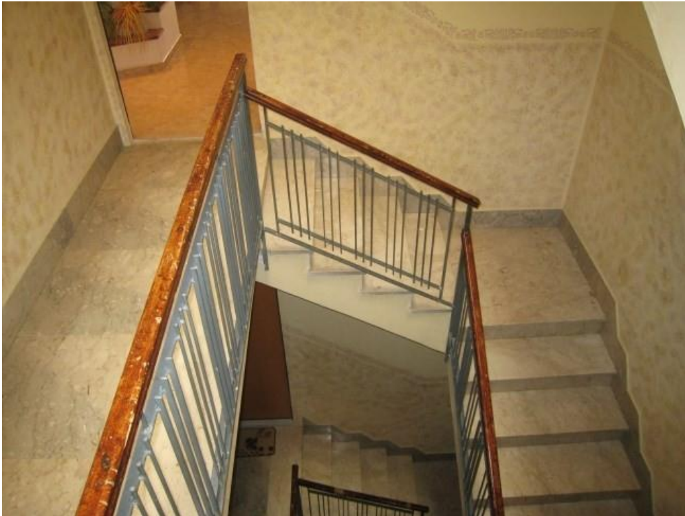
Foto n. 4. La scala condominiale realizzata in c.a. e rivestita con lastre di marmo.
