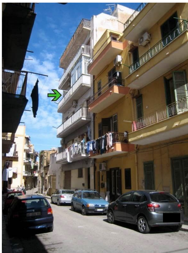
Foto n. 1. Il prospetto prospiciente la Via Gumina. La freccia verde indica l'appartamento pignorato ubicato al terzo piano dell'edificio composto da cinque elevazioni fuori terra.
