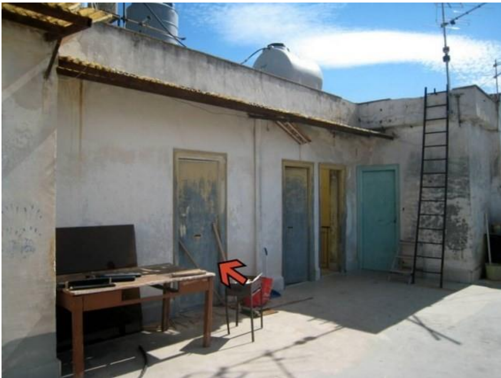
Foto n. 19. Altra immagine del vano lavanderia di pertinenza dell'appartamento.
