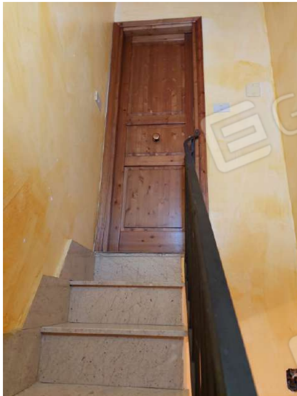
Foto 8 – Rampa di piano secondo
