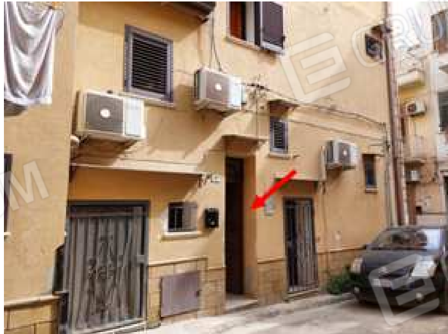
Foto 4 – Portoncino di accesso alla scala
